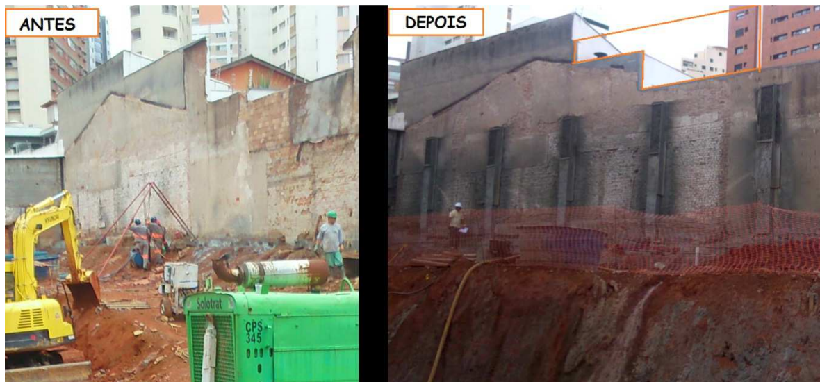
Figura 14.26 - Muro de divisa das casas, com detalhe da parte do muro retirada (25/04/14).
