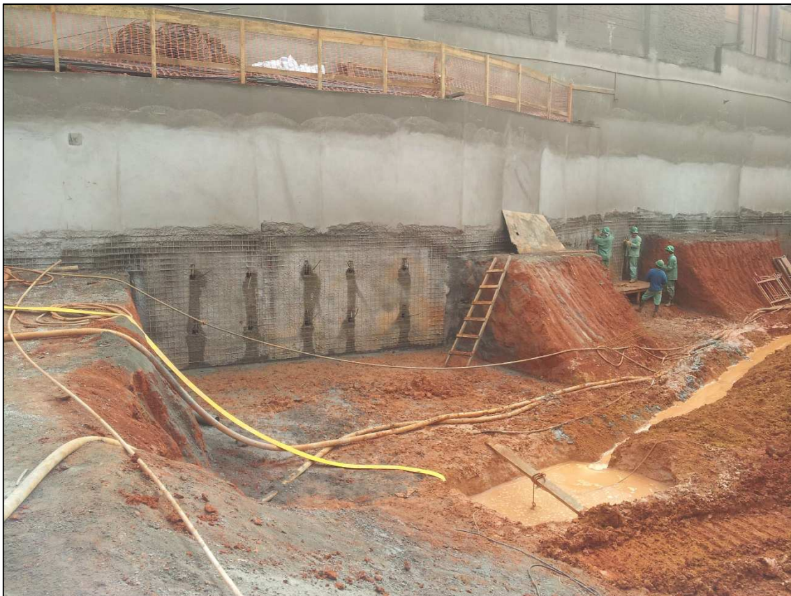
Figura 14.94 - Solo grampeado na parede do subsolo (11/07/14).
