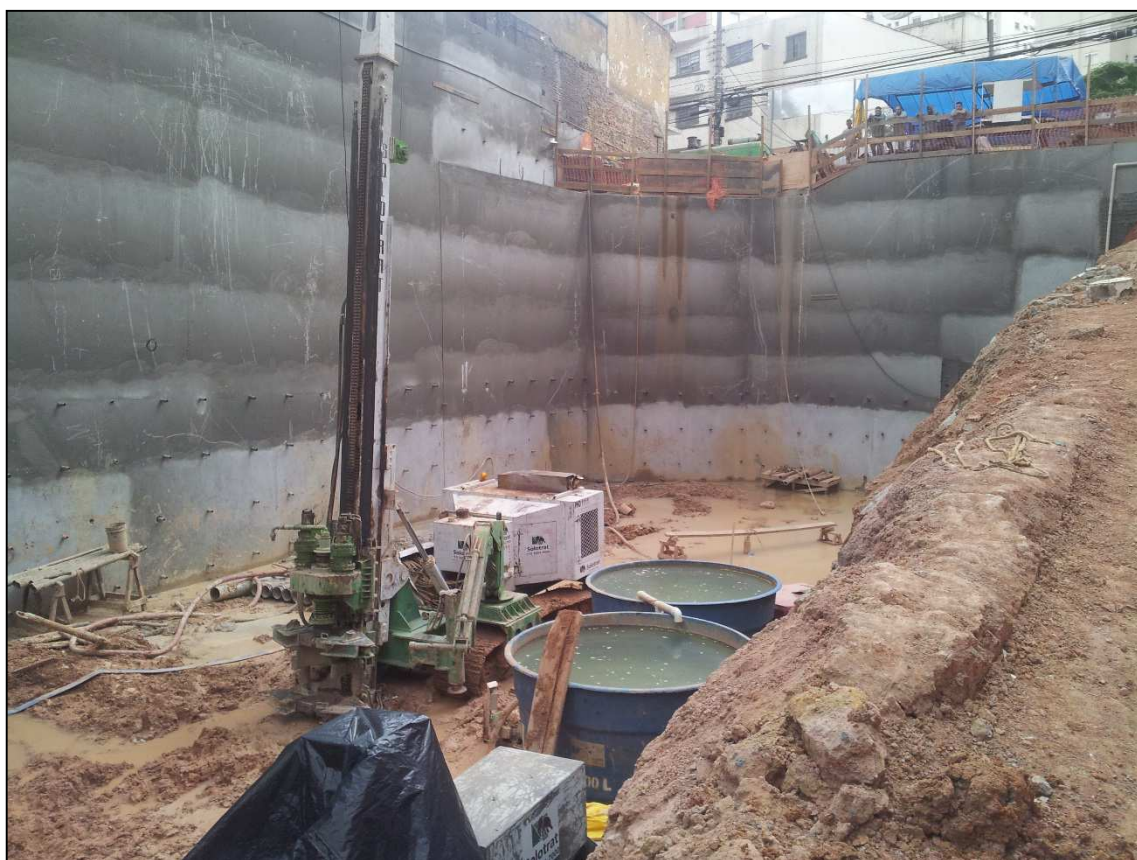
Figura 14.171 - Vista para a frente do terreno (26/09/14)
