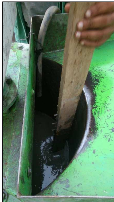
Figura 14.21 - Controle do volume de calda de cimento (16/04/14).
