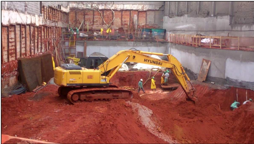
Figura 14.89 - Evolução da escavação no fundo do terreno (08/07/14).
