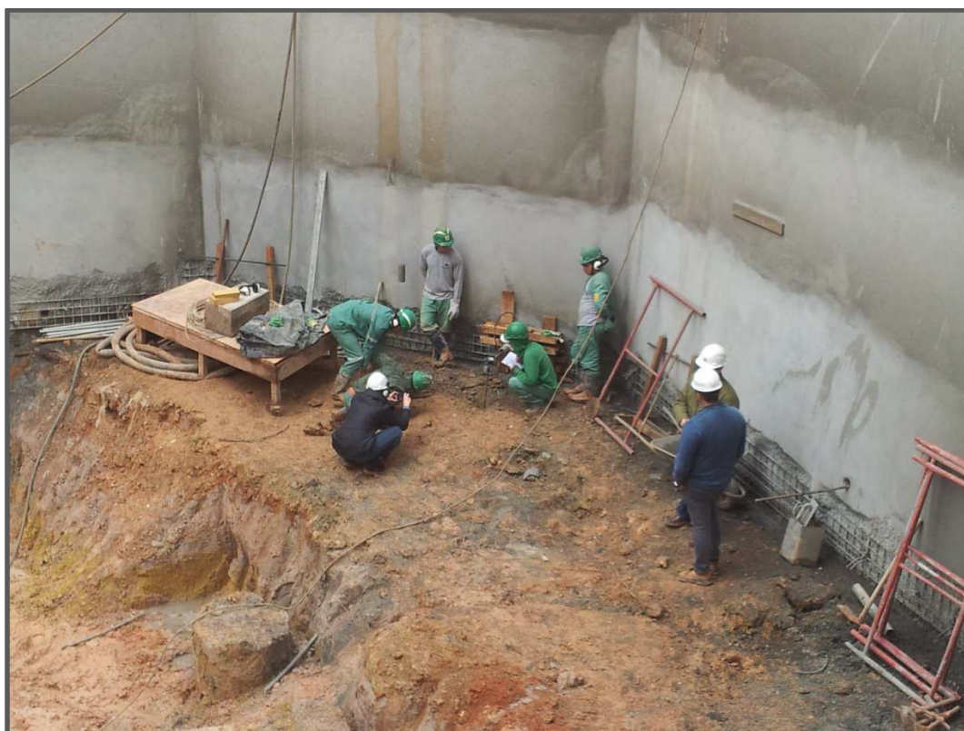
Figura 17.30 - Execução do ensaio de G.6 (15/08/14).
