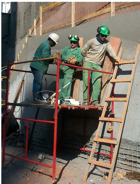
Figura 17.11 - Funcionário tentando encaixar o cravete na barra do grampo G.2. (02/07/14)
