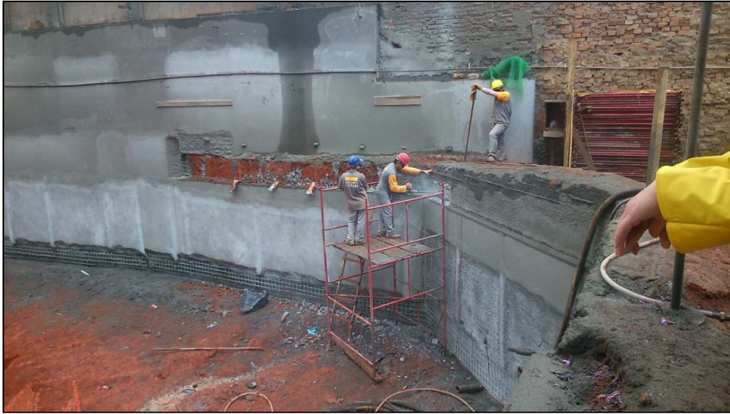
Figura 14.88 - Remoção da tela de armação (08/07/14).
