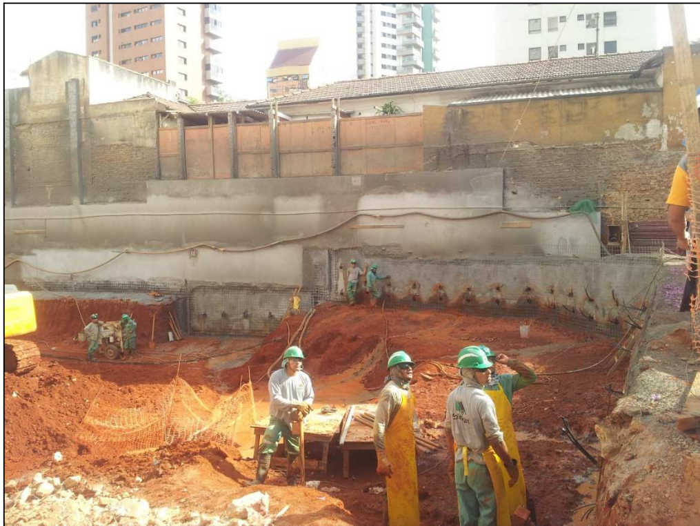
Figura 11.78 - Execução da contenção na região da frente do terreno (27/06/14).
