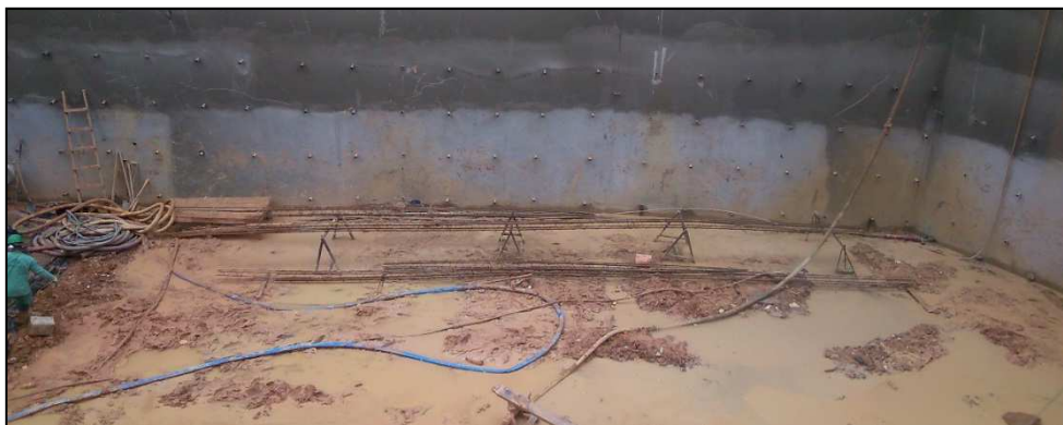
Figura 14.173 - Armação da estaca raiz (01/10/14).
