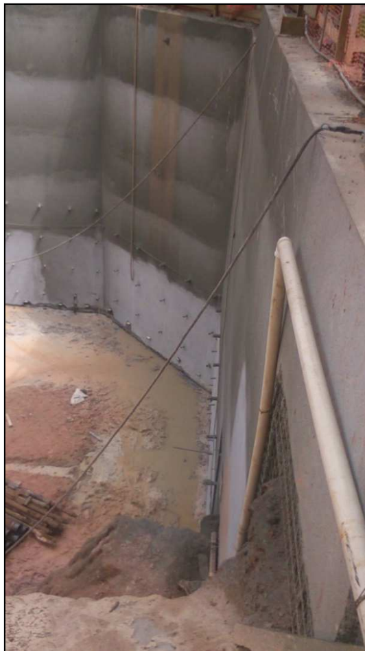
Figura 14.159 - Parede da frente da contenção (17/09/14)
