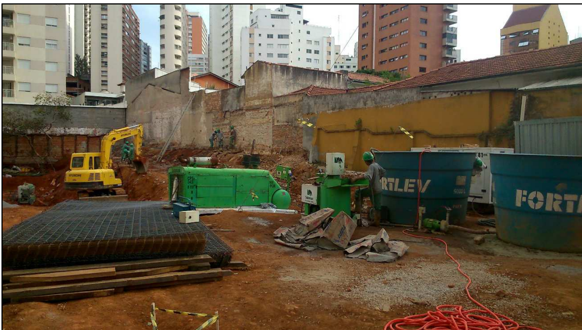
Figura 14.4 - Vista do fundo do terreno, com detalhe dos muros das casas vizinhas (09/04/14).
