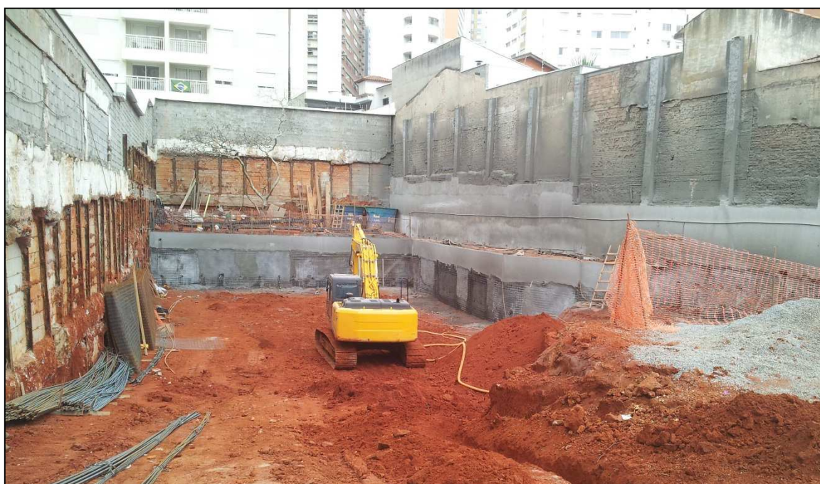
Figura 14.71 - Vista da região do fundo do terreno, já sem as bermas (20/06/14).
