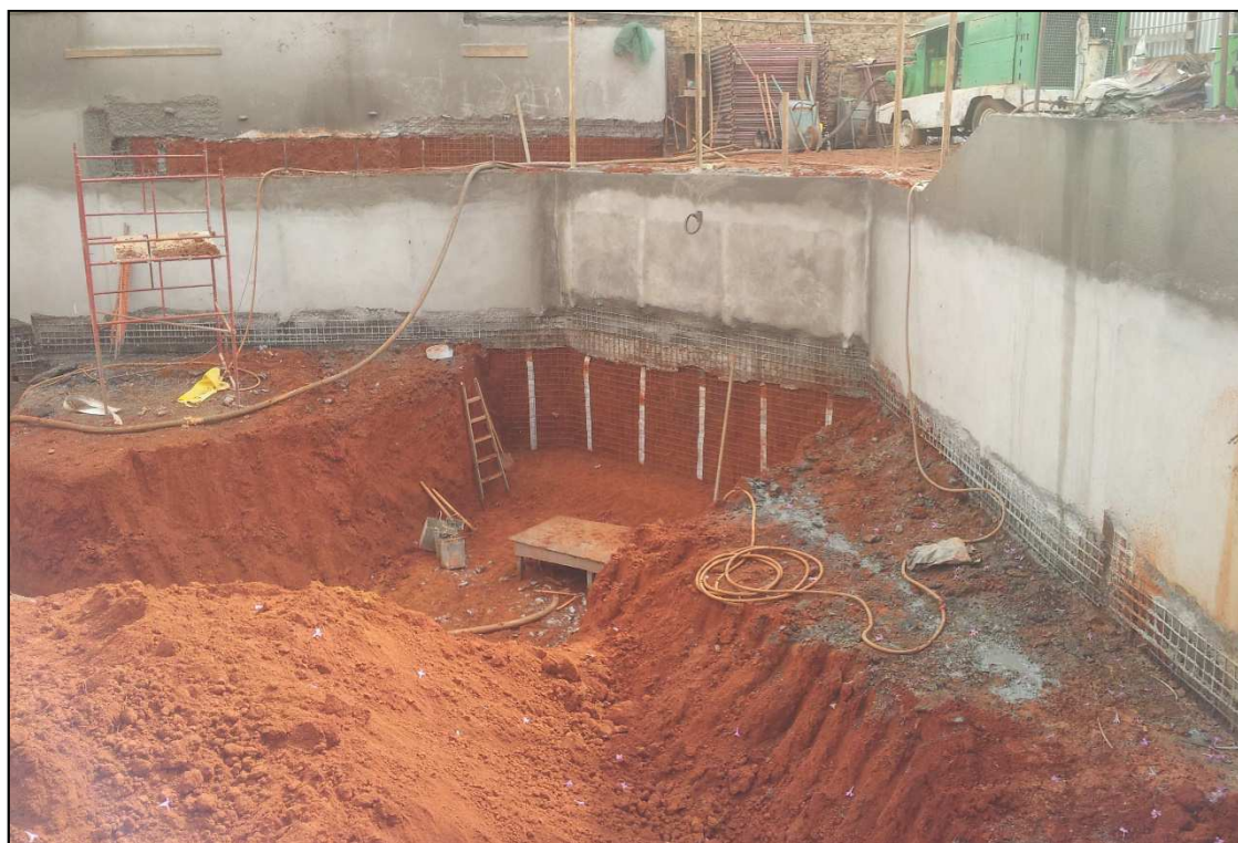
Figura 14.91 - Drenos posicionados (11/07/14).
