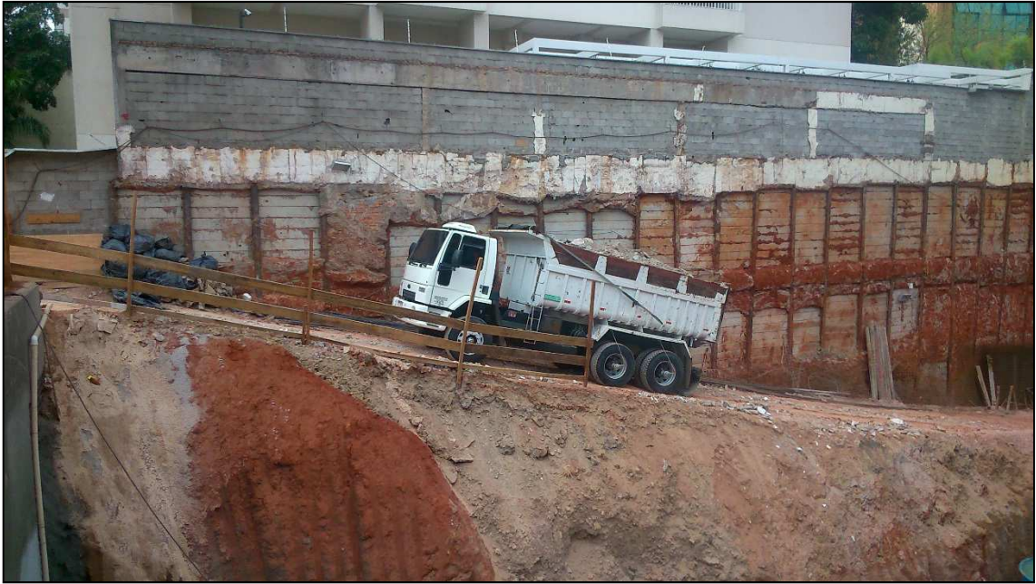
Figura 14.157 - Caminhão entrando com entulho para aterro (17/09/14)
