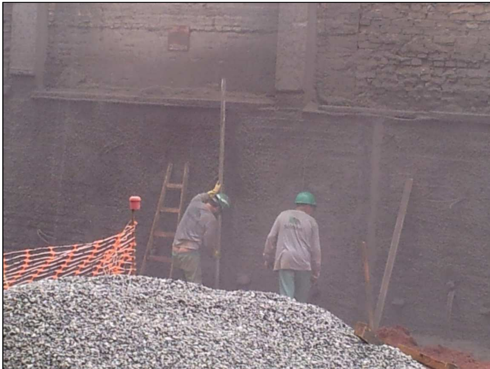
Figura 14.48 - "Alisamento" do paramento (23/05/14).
