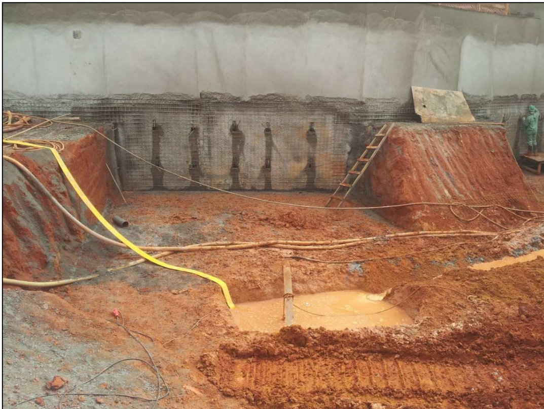
Figura 14.92 - Vala de coleta de água utilizada na lavagem dos furos da contenção (11/07/14).
