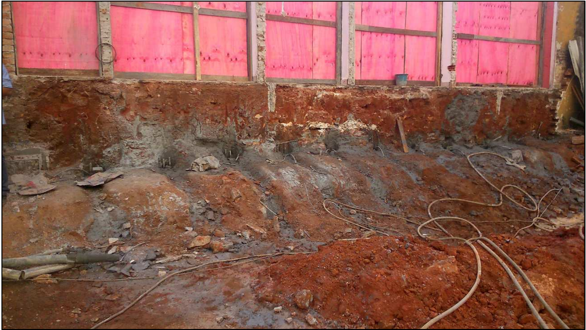
Figura 14.29 - Cavaletes do local de remoção do muro (30/04/14).
