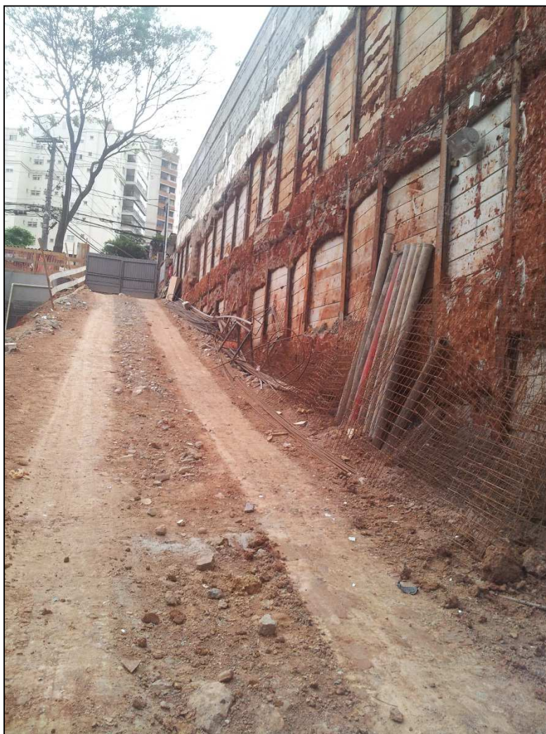
Figura 14.172 - Vista da rampa (26/09/14)
