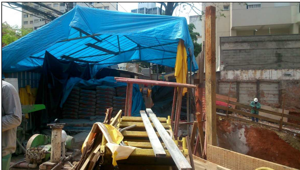
Figura 14.142 - Estoque de material na entrada do terreno (03/09/14).
