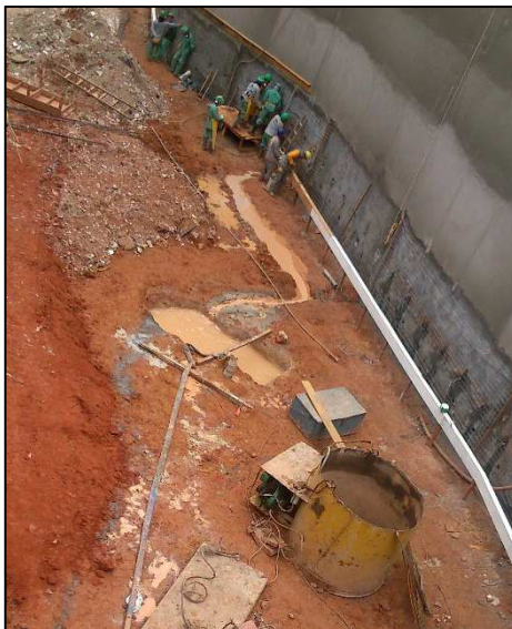
Figura 14.113 - Vala de coleta de água (29/07/14).
