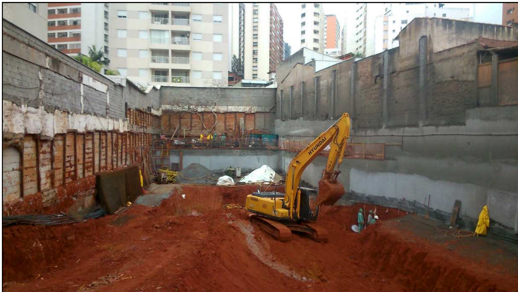
Figura 14.87 - Vista geral do canteiro no início da semana (08/07/14).
