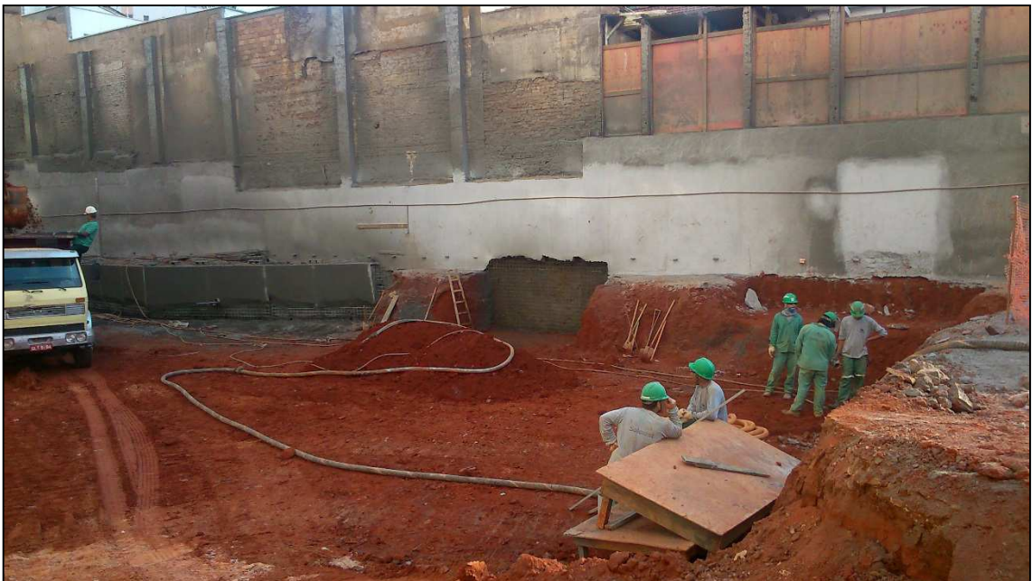
Figura 14.64 - Escavação para execução da contenção (11/06/14).
