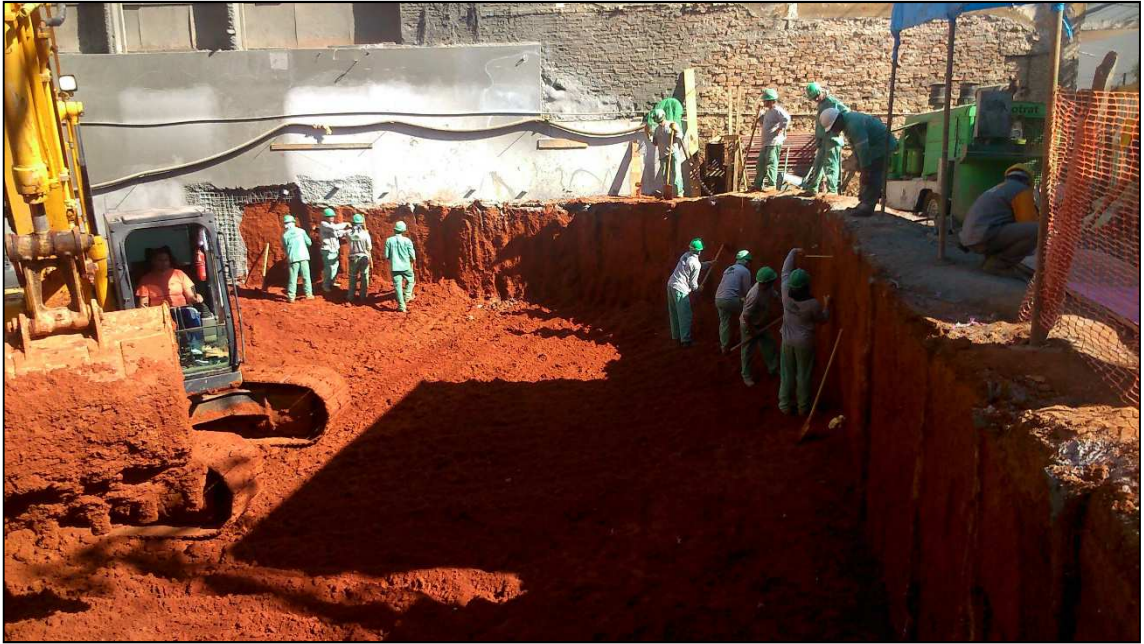
Figura 11.77 - Trabalhos na região da frente do terreno (25/06/14).
