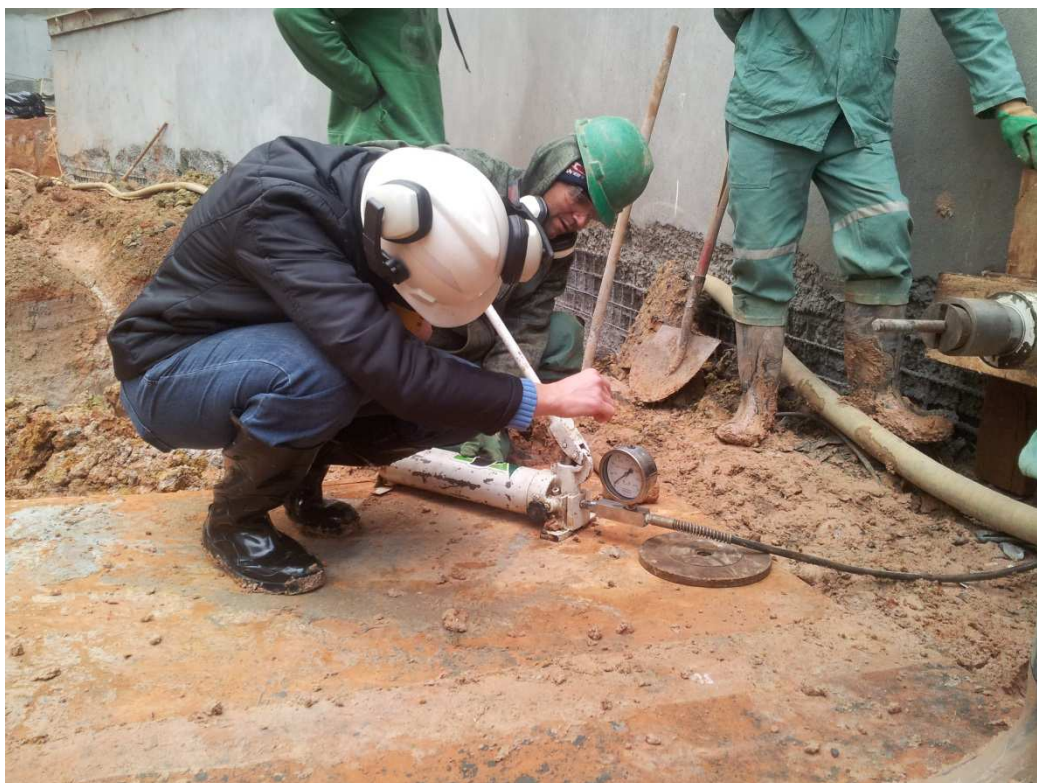
Figura 17.24 - calibração da bomba hidráulica. (15/08/14)
