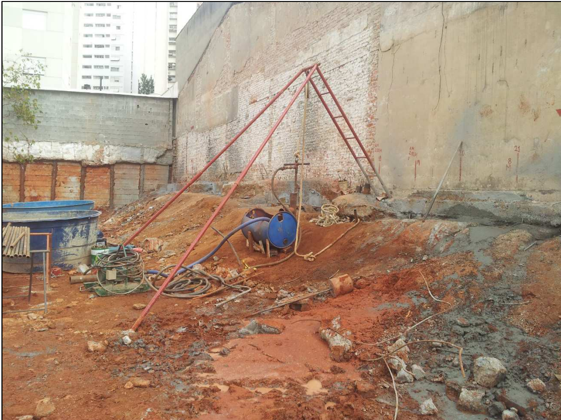
Figura 14.11 - Instalação de inclinômetro (11/04/14).
