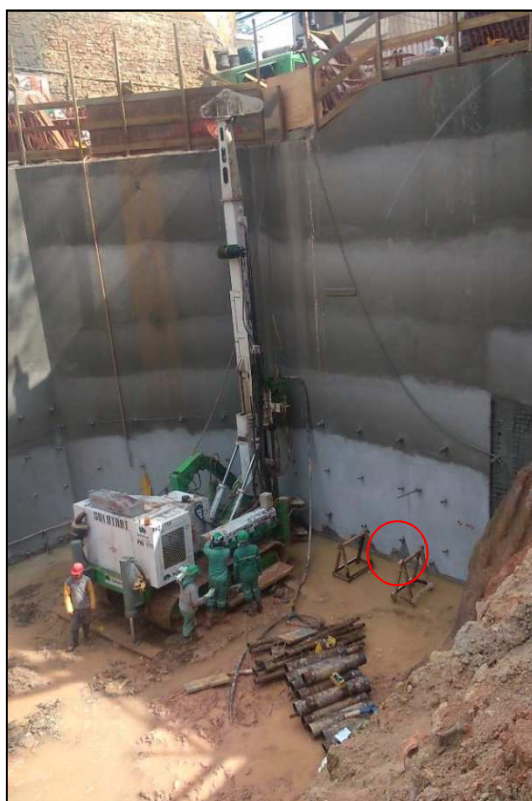
Figura 14.164 - Grampo para ensaio G.8 (18/09/14)
