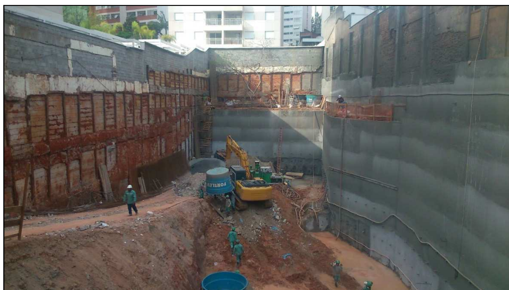
Figura 14.162 - Vista geral do canteiro (18/09/14)
