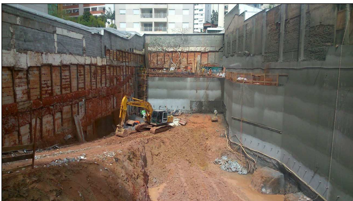
Figura 14.145 - Vista do fundo do terreno (03/09/14)
