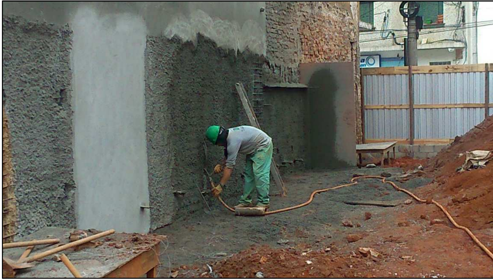
Figura 14.52 - Preenchimento grampo horizontal (28/05/14).
