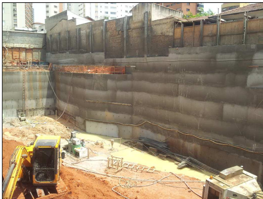
Figura 14.189 - Vista da parede lateral, na divisa com as casas. (17/10/14)
