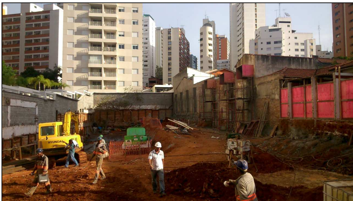
Figura 14.31 - Vista geral do canteiro. (30/04/14)
