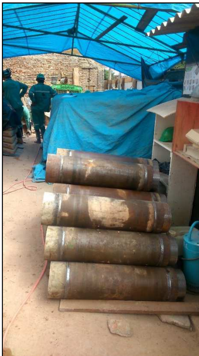
Figura 14.155 - Tubos de revestimento para estacas raiz armazenados no canteiro (17/09/14)
