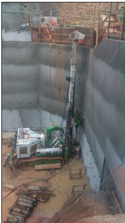
Figura 14.161 - Equipamento de execução das estacas-raiz posicionado na região da frente do terreno (18/09/14)
