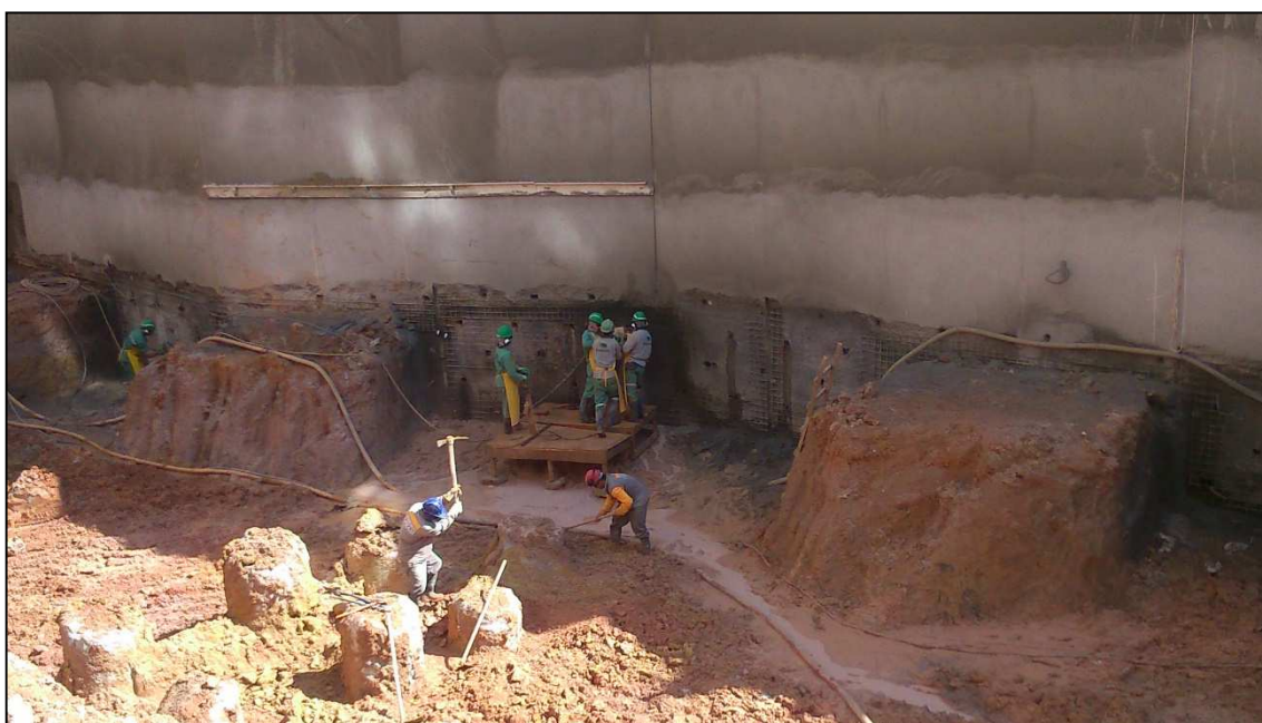
Figura 14.129 - Execução de grampos na lateral do terreno (20/08/14).
