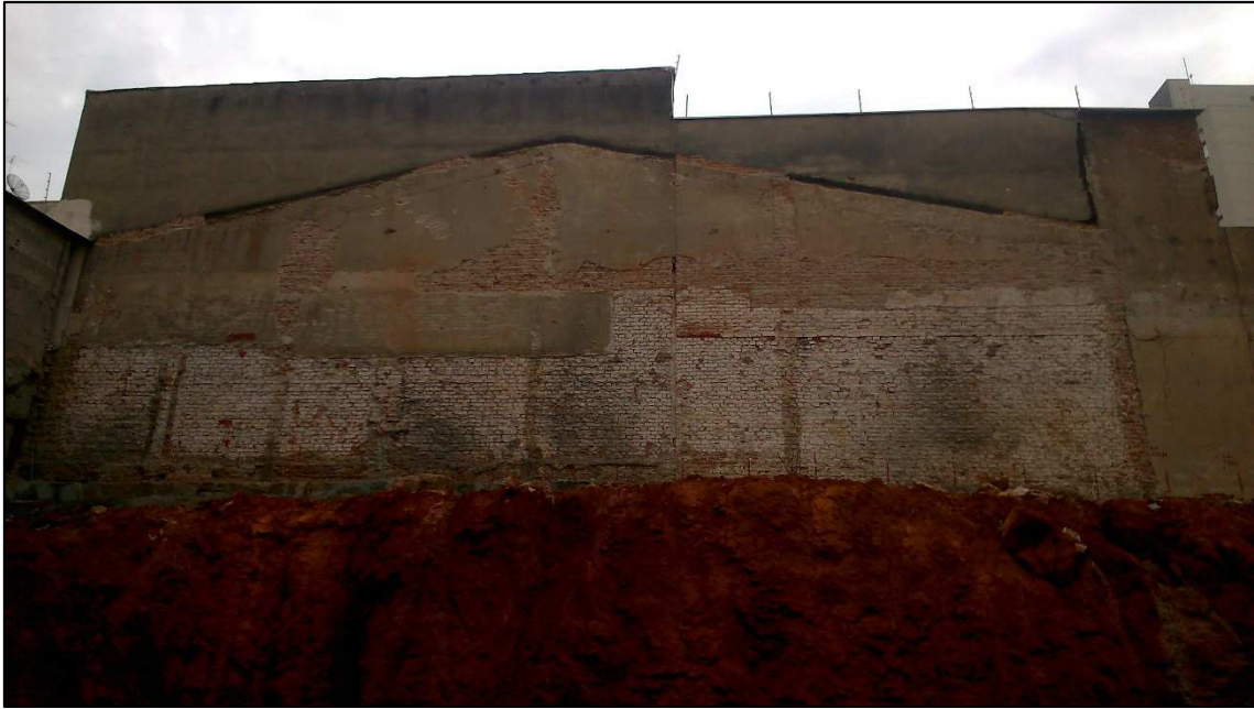
Figura 14.5 - Detalhe do muro da casa localizada próxima ao fundo do terreno. Região em que o muro de divisa possui maior altura, como pode ser visualizado na figura anterior (09/04/14).
