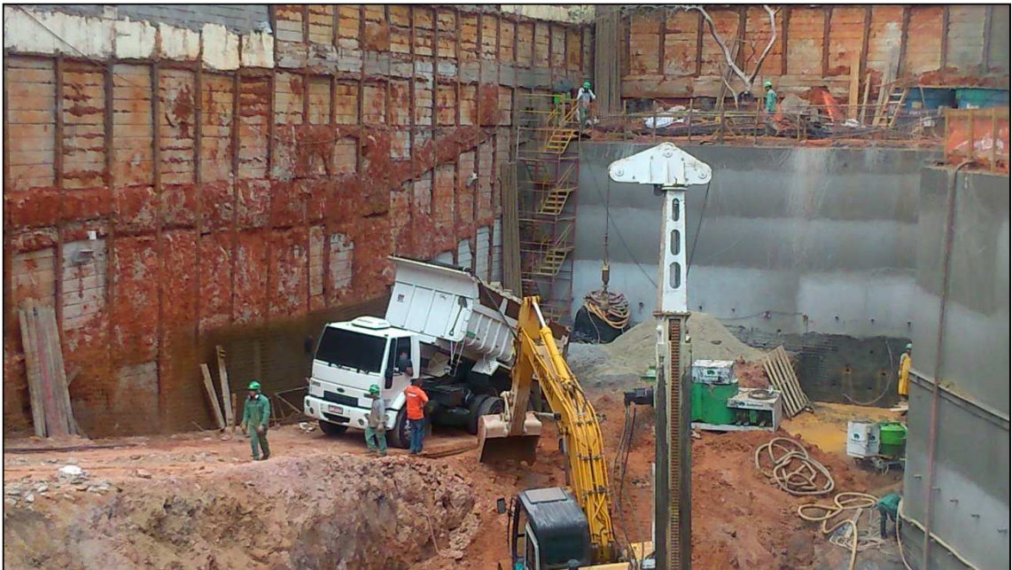
Figura 14.158 - Vista do fundo do terreno (17/09/14)
