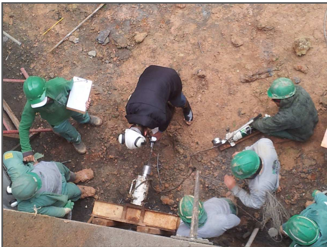
Figura 17.29 - Execução do ensaio de G.6. (15/08/14)
