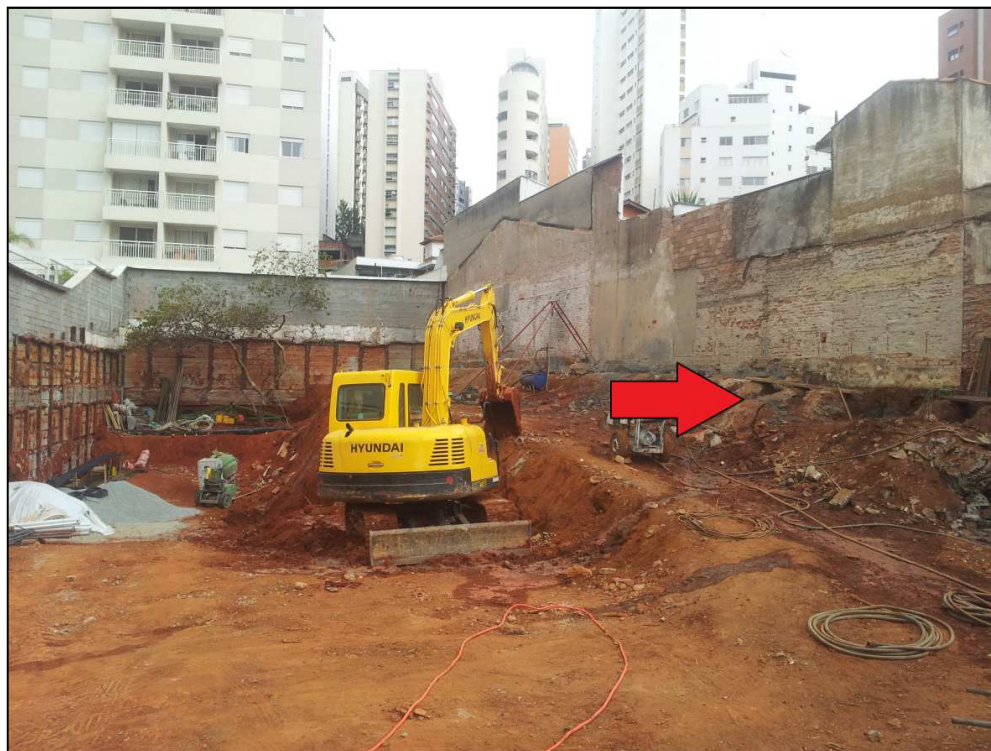
Figura 14.15 - Detalhe do local de execução dos cavaletes. (11/04/14)
