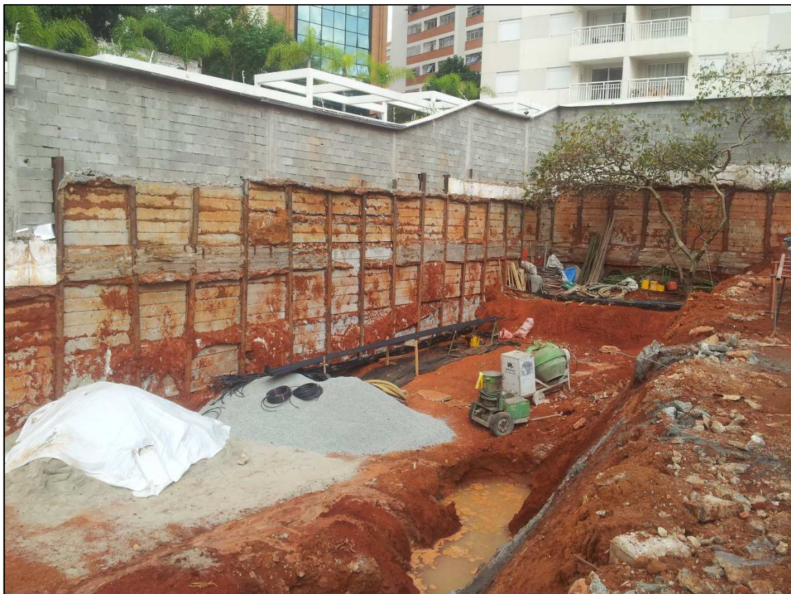
Figura 14.8 - Detalhe da contenção dos prédios vizinhos (11/04/14).
