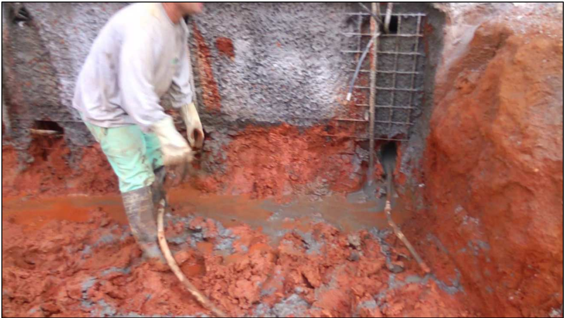
Figura 14.34 - Furo Preenchido com calda de cimento (07/05/14).
