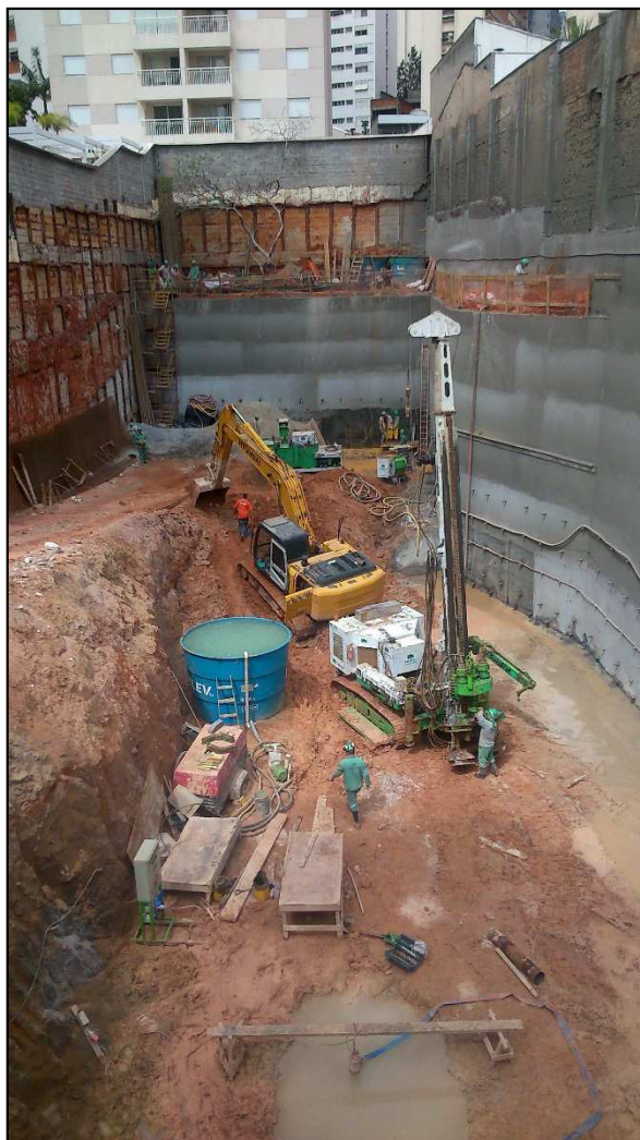
Figura 14.154 - Vista geral do canteiro no início da semana (17/09/14)
