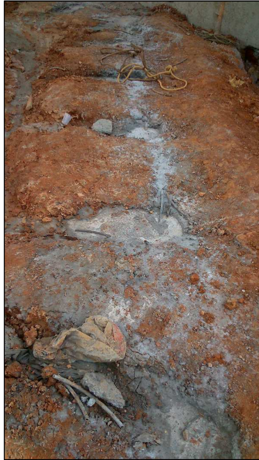
Figura 14.60 - Topo de grampos verticais (05/06/14).
