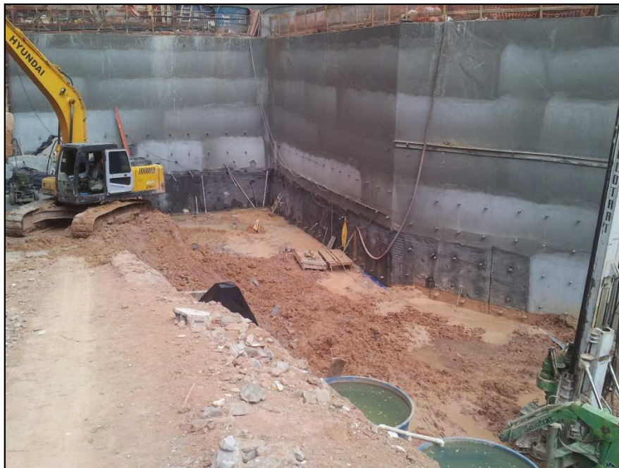
Figura 14.170 - Vista do fim da rampa e dos trabalhos na região do fundo do terreno (26/09/14)
