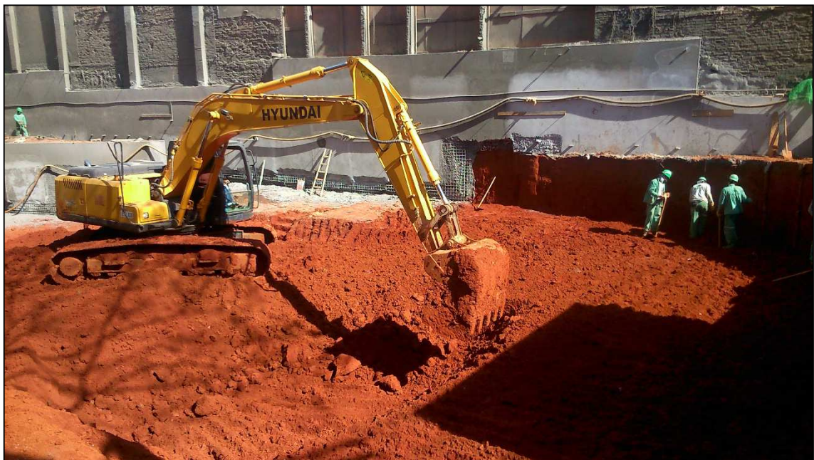
Figura 11.76 - Escavação deixando faixa de trabalho (25/06/14).
