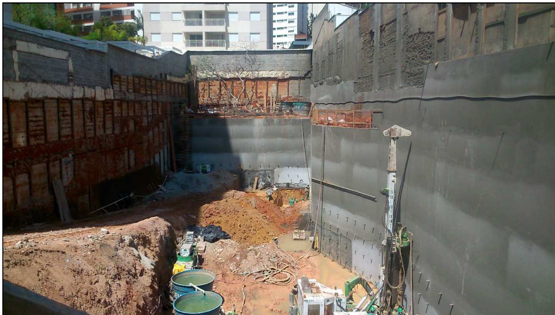
Figura 14.165 - Vista geral do canteiro no início da semana. (25/09/14)
