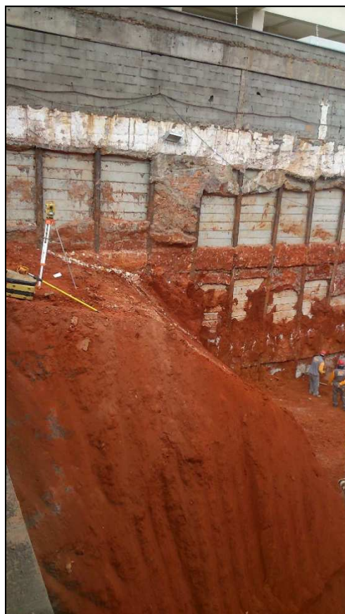
Figura 14.111 - Rampa retirada para execução da fundação (29/07/14).
