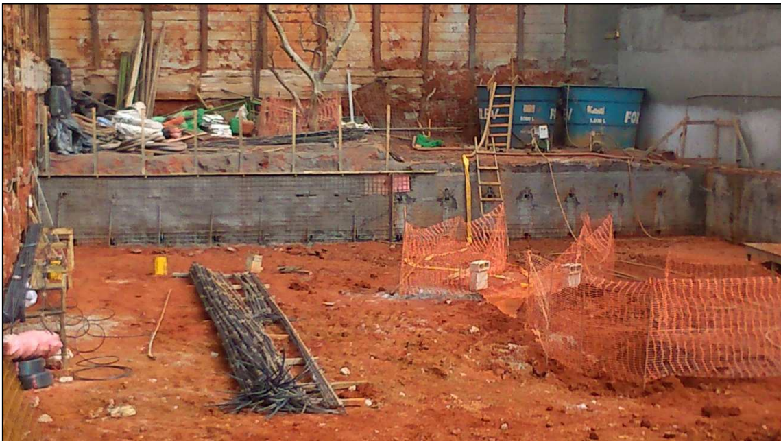
Figura 14.57 - Segunda linha de grampos no fundo (05/06/14).
