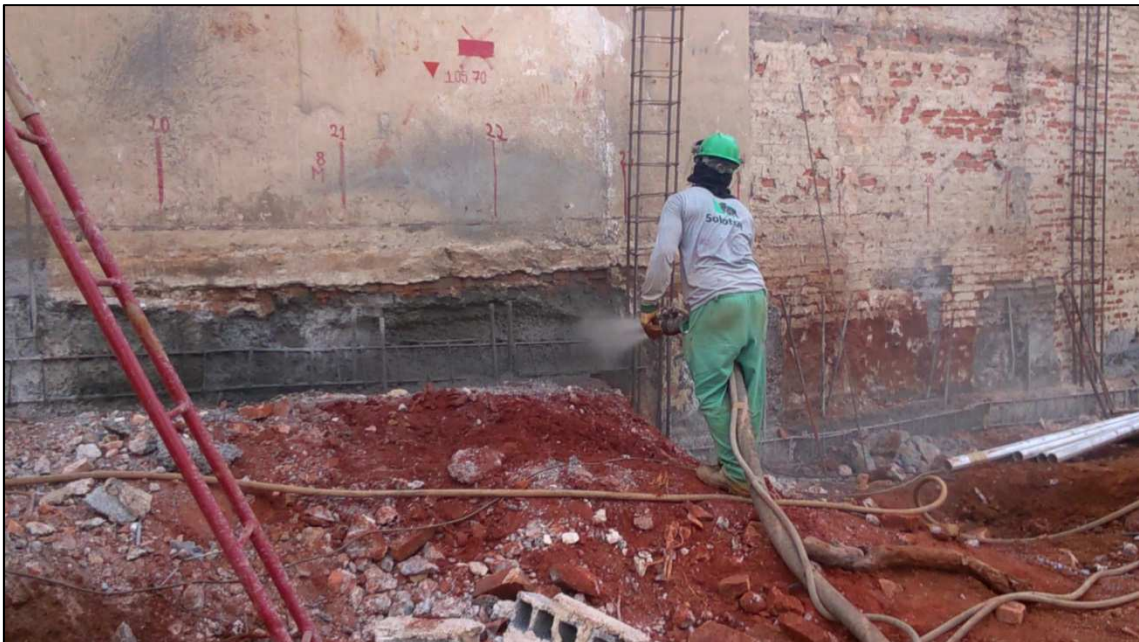
Figura 14.23 - Execução concreto projetado (23/04/14).
