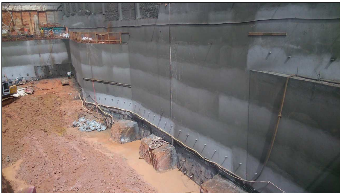
Figura 14.144 - Vista da parede lateral do terreno, na divisa com as casas (03/09/14)
