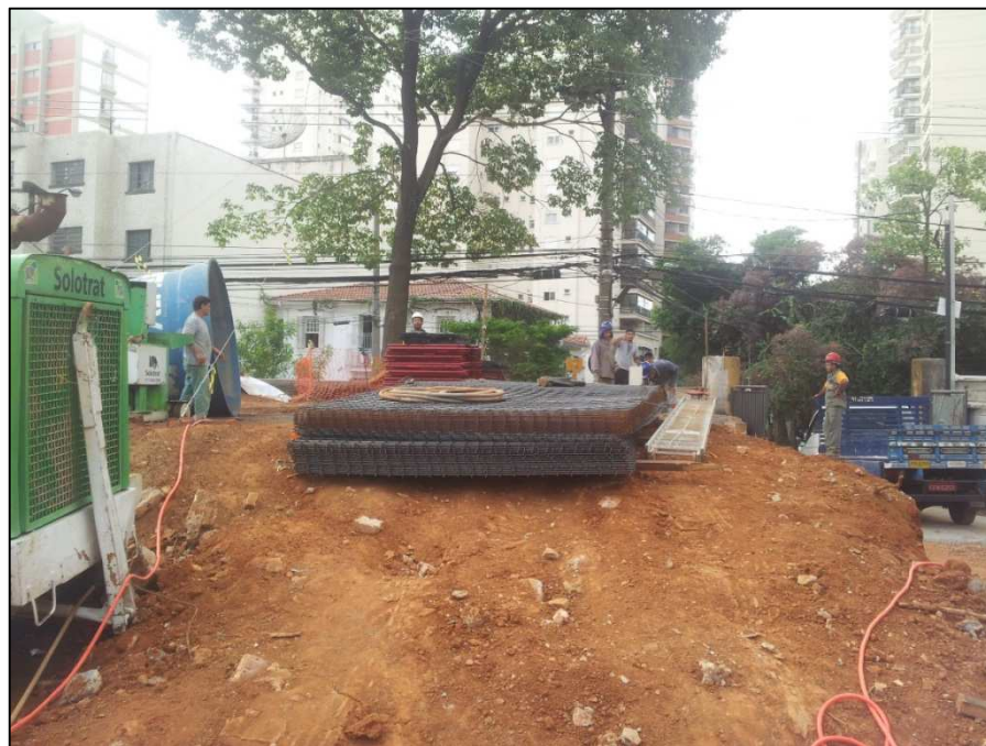
Figura 14.13 - Detalhes das telas já entregues no canteiro e andaimes (vermelhos), dispostos atrás das telas (11/04/14).
