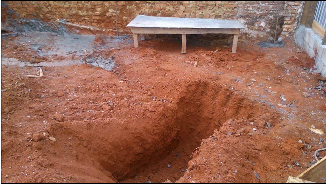
Figura 14.55 - Vala escavada para a coleta de água. (28/05/14)
