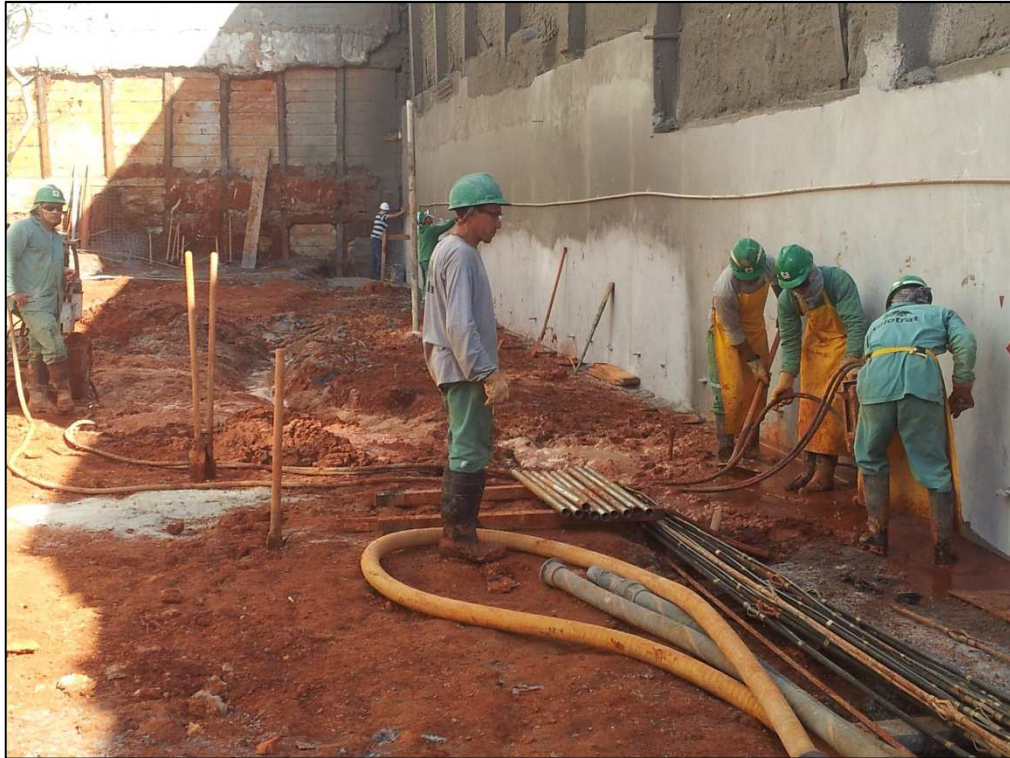
Figura 14.53 - Perfuração de grampo vertical. Pode-se visualizar o caminho feito para a água correr até a vala (30/05/14).
