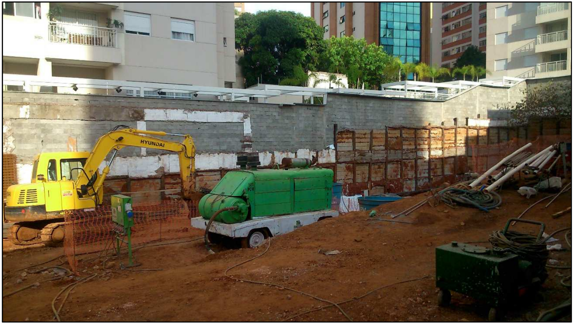
Figura 14.7 - Foto da lateral do terreno, em que é possível visualizar parte do prédio residencial vizinho (Torre Figueira – Condomínio Vergê Perdizes), localizado na lateral do terreno oposta às casas (30/04/14).
