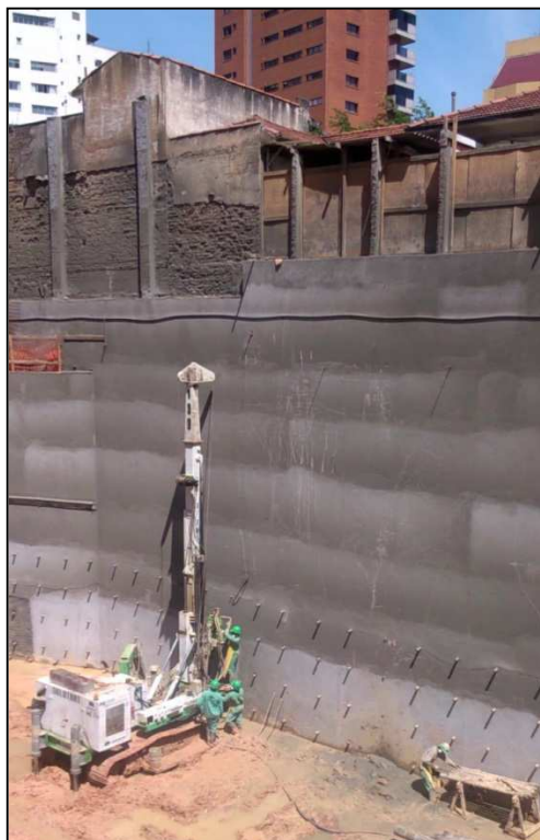
Figura 14.168 - Perfuração de estaca raiz nas proximidades da parede lateral (25/09/14)
