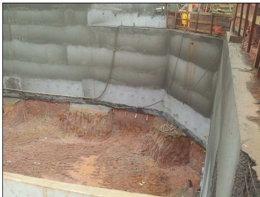
Figura 14.139 - Parede lateral com bermas (29/08/14).
