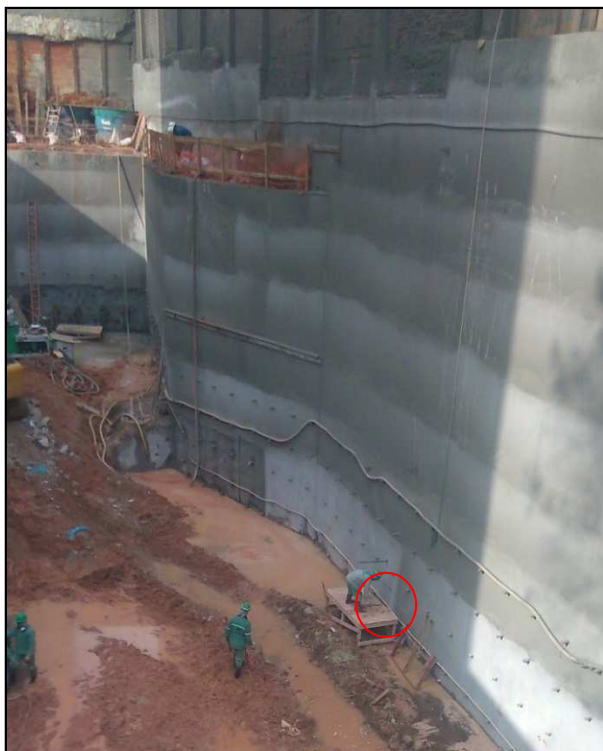
Figura 14.163 - Grampo para ensaio G.7 (18/09/14)
