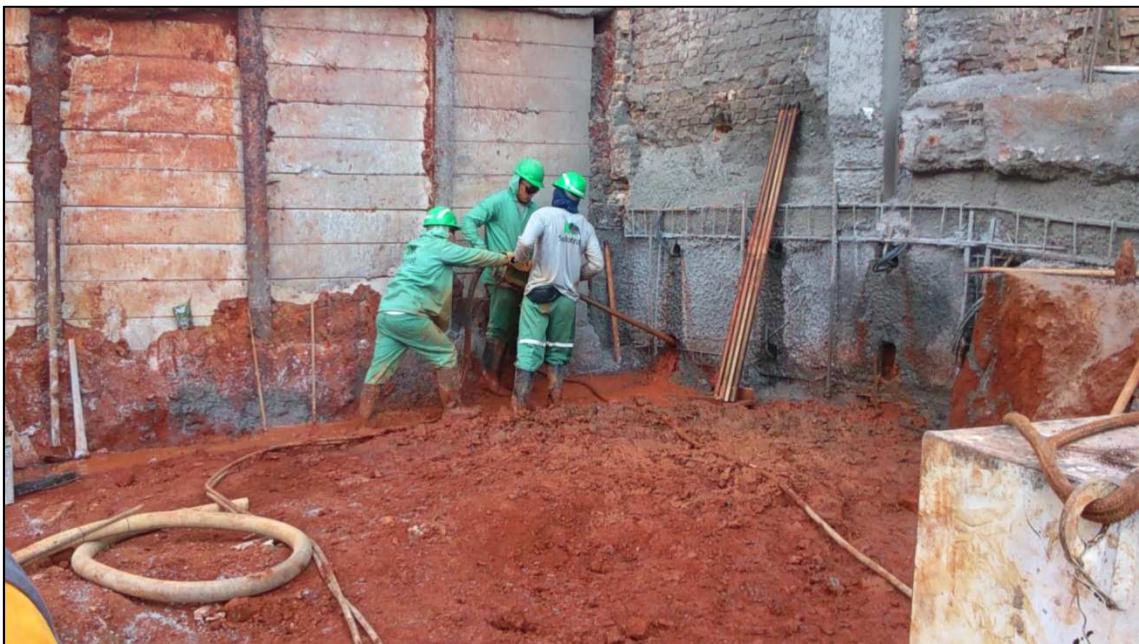
Figura 14.36 - Perfuração de grampo. (07/05/14)
