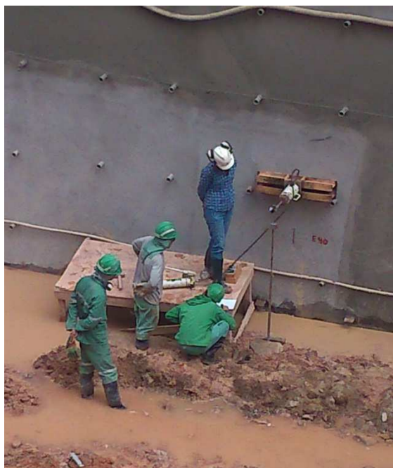
Figura 17.37 - Execução do ensaio de G.7. (18/09/14)
