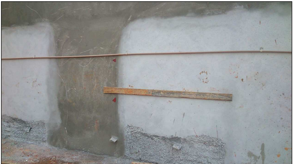
Figura 14.61 - Gabarito na parede de contenção (05/06/14).
