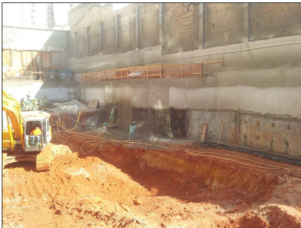
Figura 14.100 - Execução do concreto projetado e acabamento com sarrafeamento (17/07/14).
