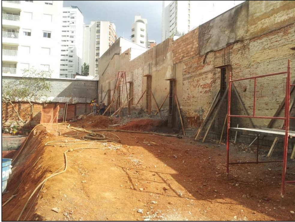
Figura 14.27 - Detalhe da execução dos pilares (25/04/14).
