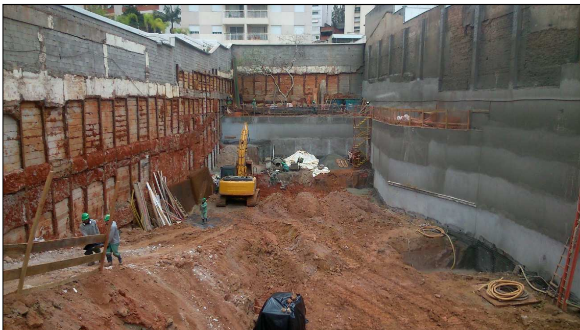
Figura 14.122 - Vista geral do canteiro no começo da semana (13/08/14).
