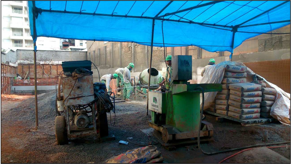
Figura 14.67 - Tenda das bombas e operador fazendo a irrigação das britas (11/06/14).
