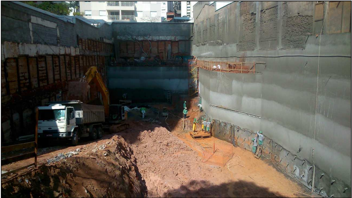
Figura 14.134 - Vista geral do canteiro no começo da semana (27/08/14).
