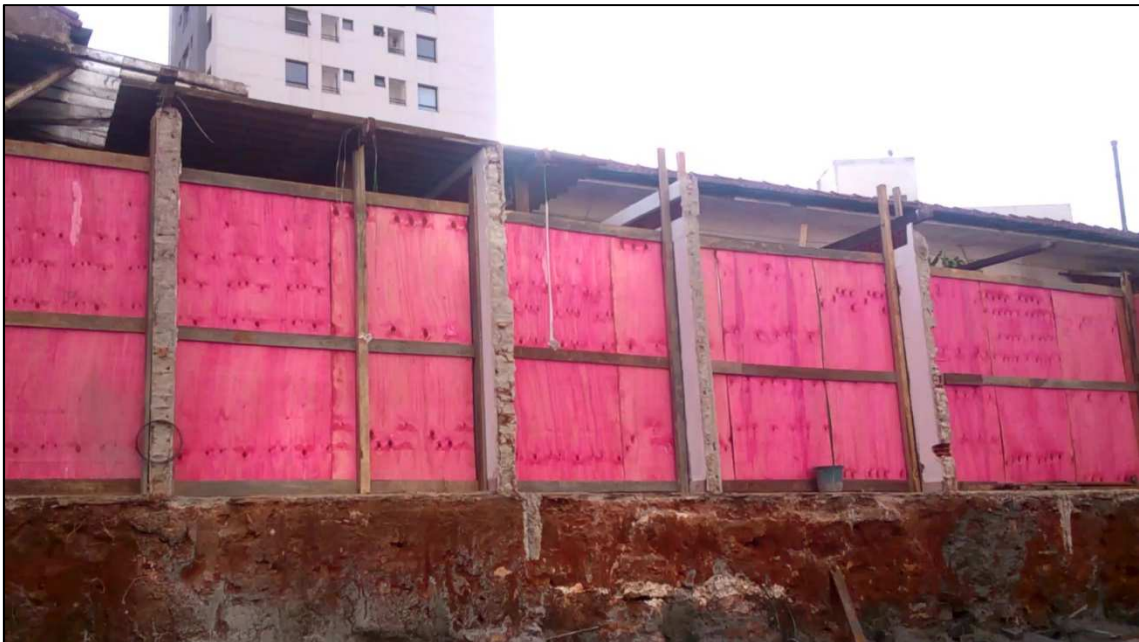
Figura 14.30 - Local da remoção do muro (30/04/14).
