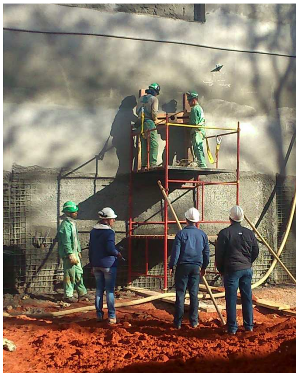
Figura 17.10 - Posicionamento da mesa de reação para o grampo G.3. (02/07/14)
