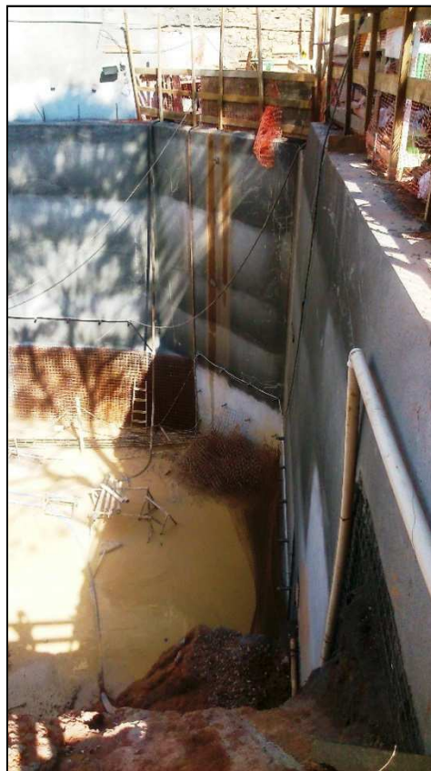
Figura 14.182 - Vista do chanfro da frente do terreno. (08/10/14)
