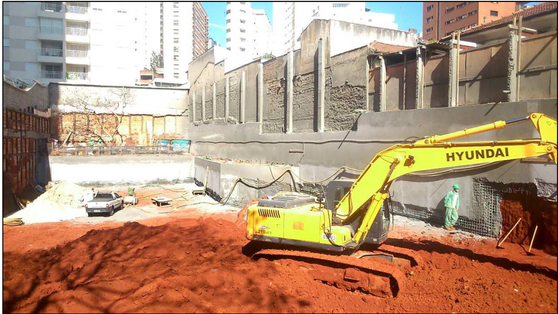
Figura 14.75 - Vista geral do canteiro no início da semana (25/06/14).
