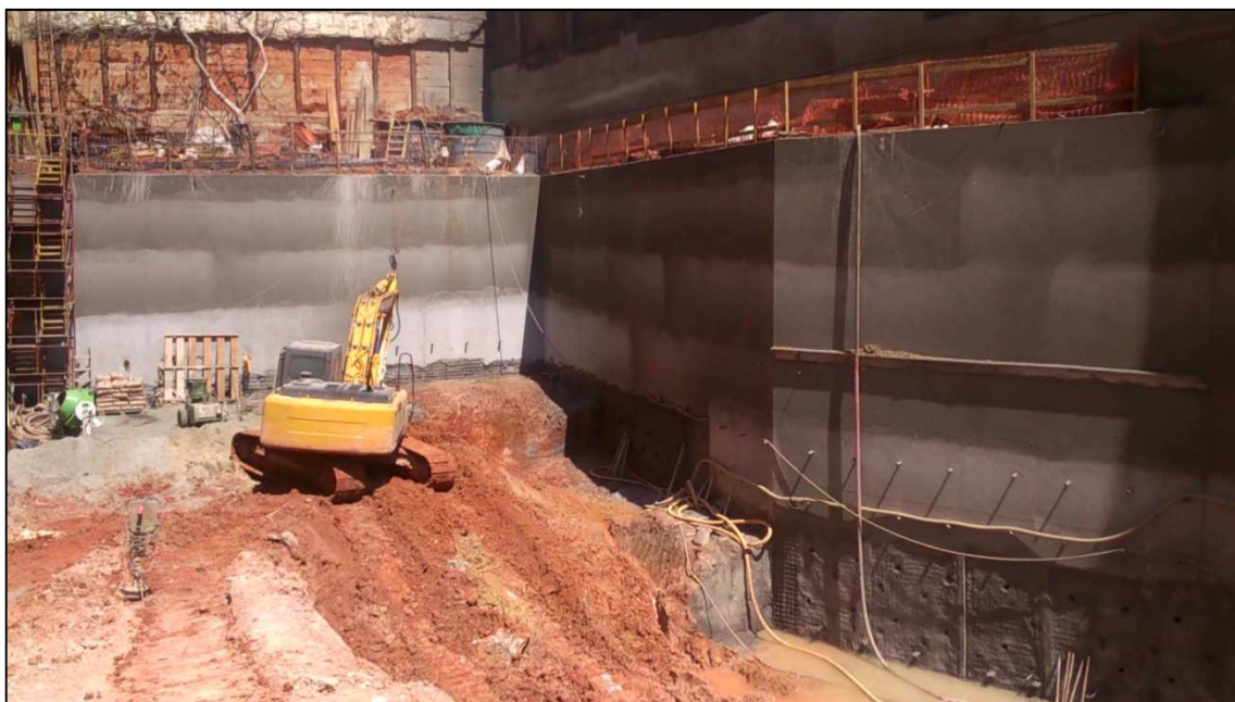
Figura 14.152 - Vista do fundo do terreno (11/09/14)
