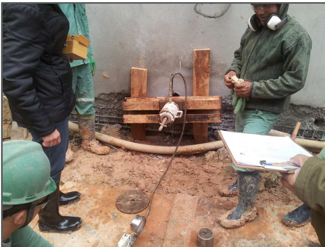
Figura 17.23 - Montagem do equipamento para o ensaio do grampo G.4. (15/08/14)
