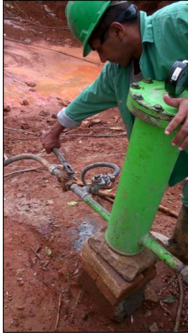
Figura 14.20 - Ajuste da bomba de injeção (16/04/14).
