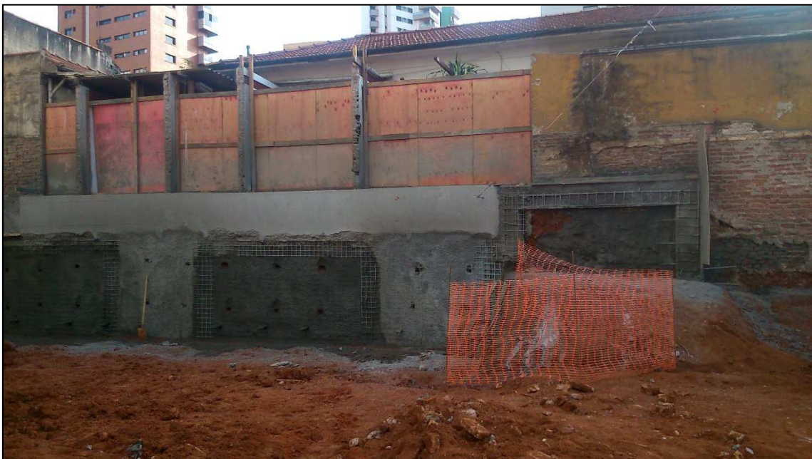
Figura 14.46 - Solo grampeado até a cota do térreo 101,14 (21/05/14).
