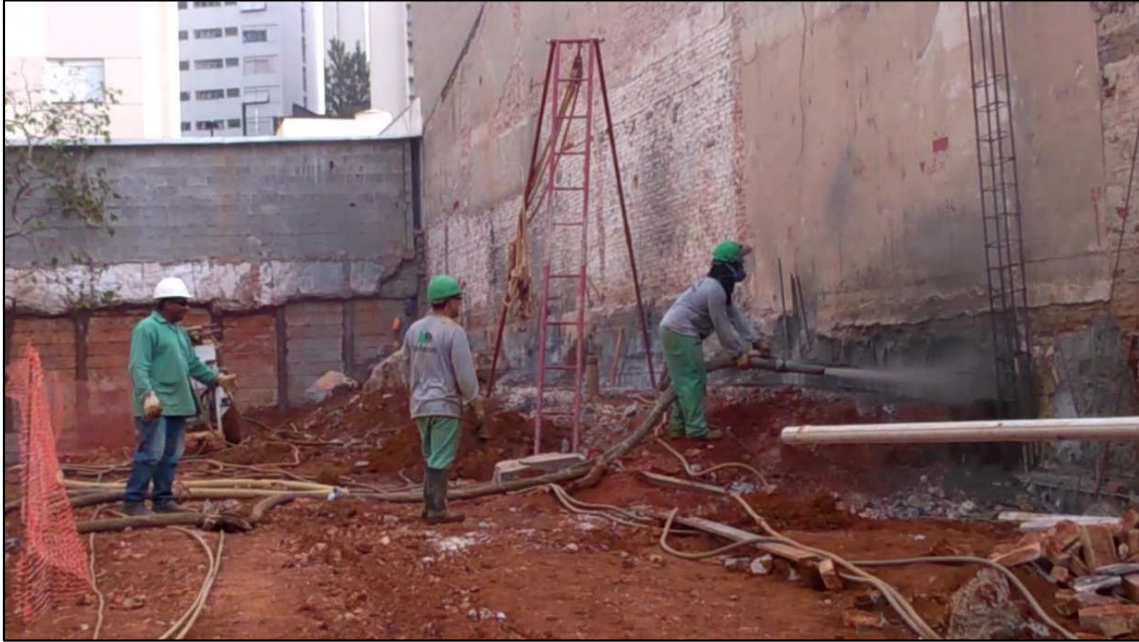
Figura 14.22 - Execução concreto projetado (23/04/14).
