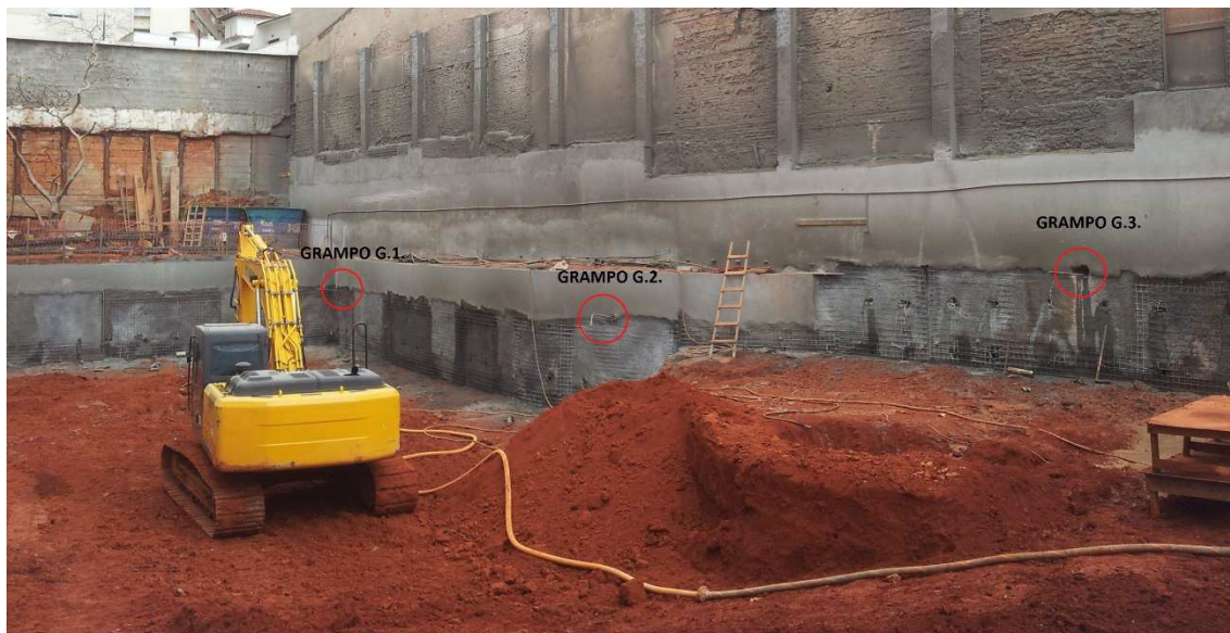
Figura 17.6 - Localização dos Grampos de ensaio G.1, G.2 e G.3. (20/06/14)
