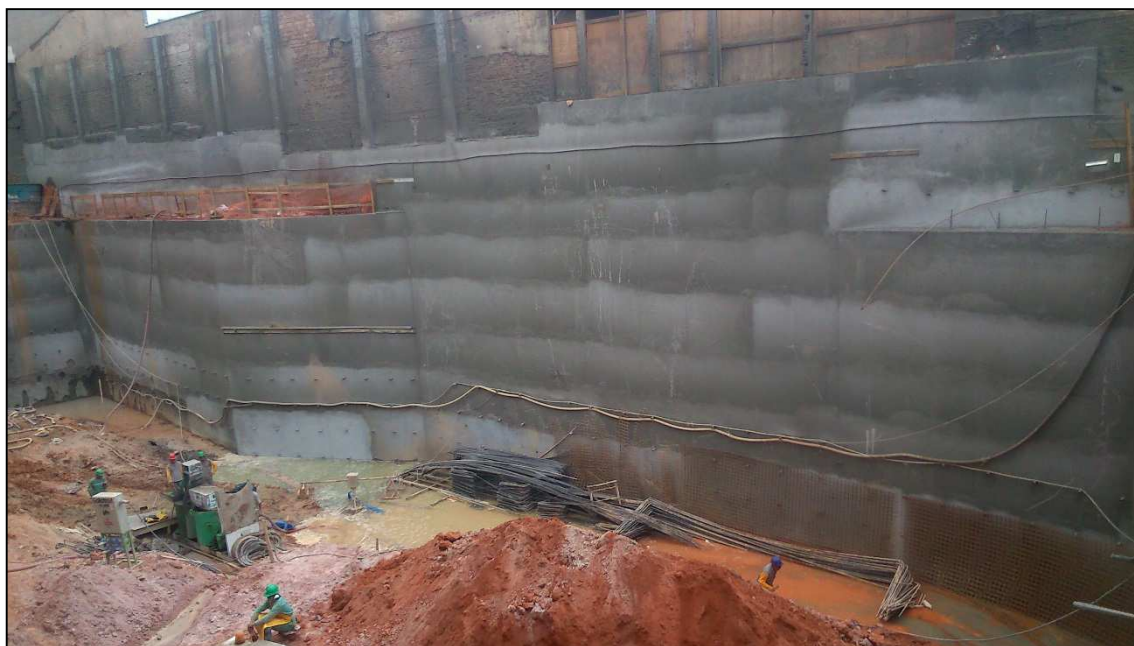
Figura 14.187 - Armação dos blocos. (15/10/14)
