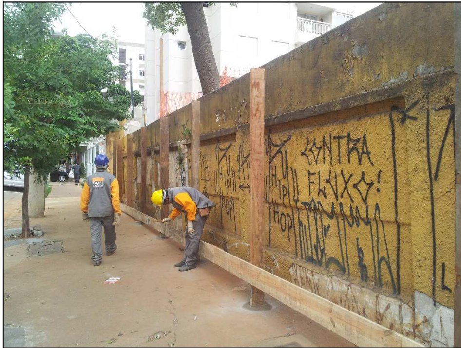
Figura 14.39 - Detalhe da proteção da colocação das ripas (09/05/14).
