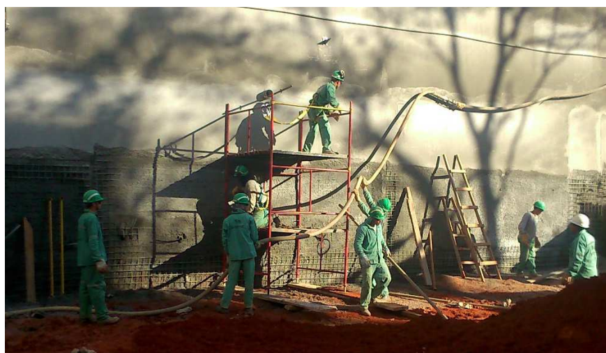
Figura 17.13 - Andaime posicionado para a execução do ensaio no grampo G.1. (02/07/14)
