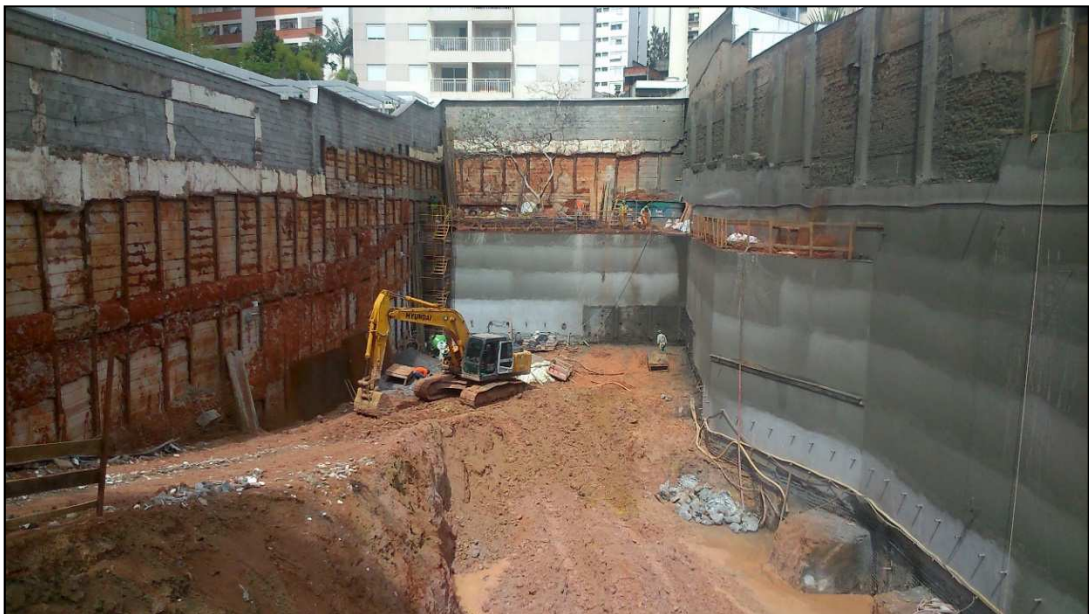
Figura 14.141 - Vista geral do canteiro no início da semana (03/09/14).
