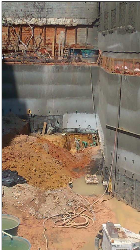
Figura 14.167 - Trabalhos no fundo do terreno (25/09/14)
