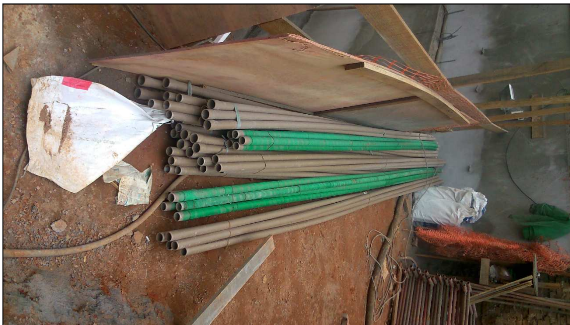
Figura 14.114 - Tubos para os DHP's (somente os não revestidos) (29/07/14).
