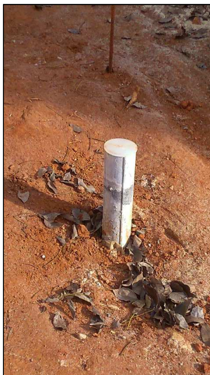
Figura 14.49 - Topo do inclinômetro após corte de uma parte de seu tubo (21/05/14).
