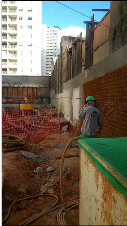
Figura 14.69 - Vista da parede lateral das casas (11/06/14).
