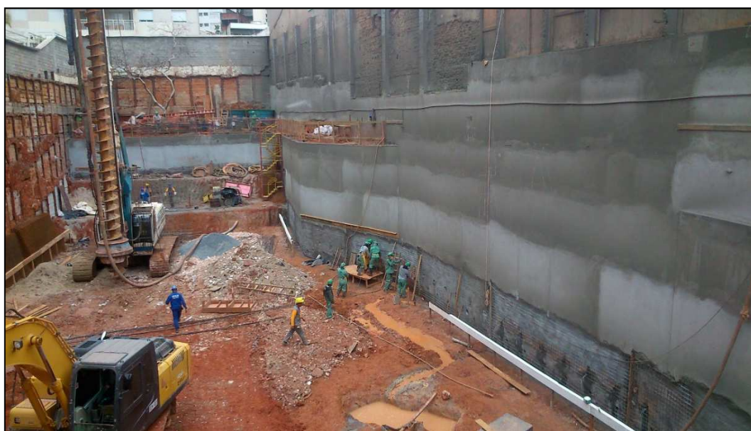
Figura 14.109 - Execução de grampos na lateral do terreno (29/07/14).
