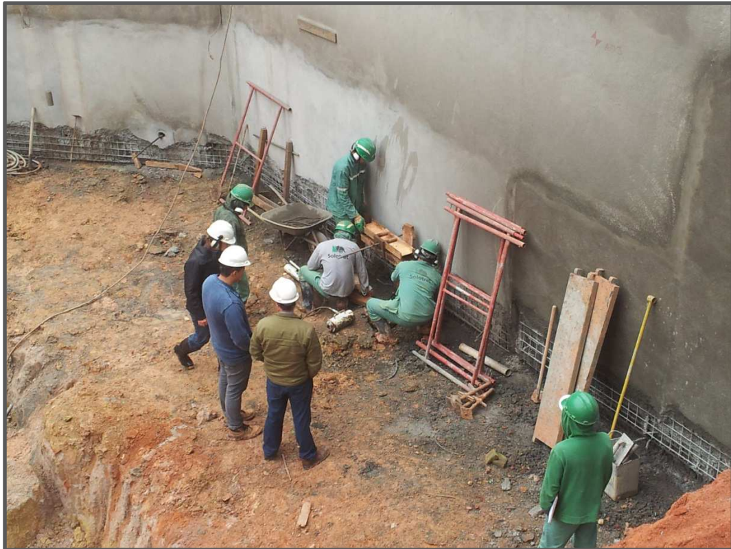
Figura 17.31 - Execução do ensaio de G.5. (15/08/14)
