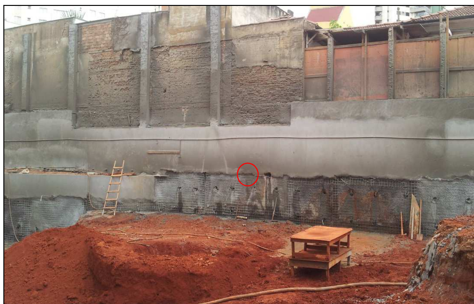
Figura 14.74 - Grampo de ensaio já executado (20/06/14).
