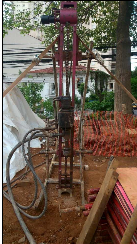
Figura 14.25 - Perfuratriz do segundo inclinômetro posicionada na entrada do terreno (23/04/14).
