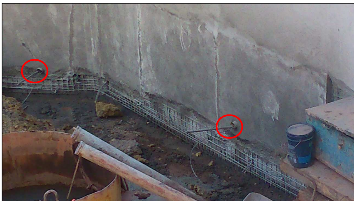
Figura 17.22 - G.5 e G.6 (à esquerda) na parede do subsolo na entrada do terreno. (06/08/14)
