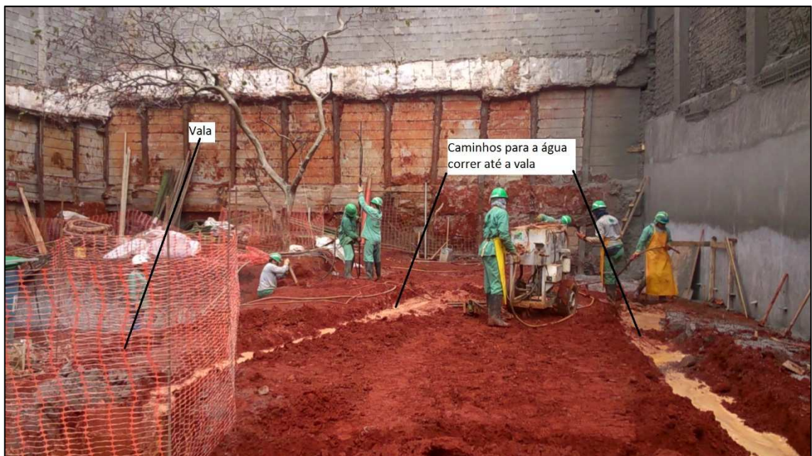
Figura 14.54 - Detalhe dos caminhos para a água da lavagem dos furos seguir até a vala de armazenamento. (28/05/14)
