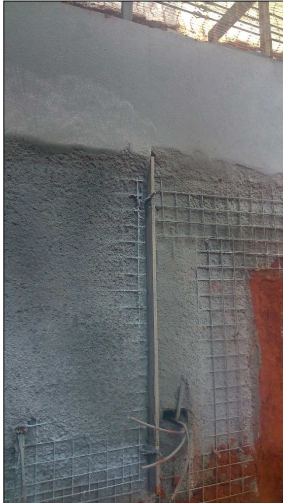
Figura 14.72 - Execução da junta de dilatação (19/06/14).
