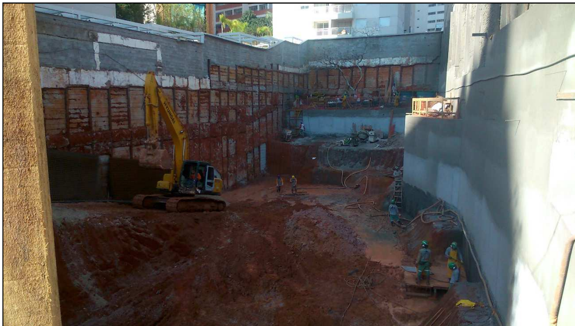
Figura 14.104 - Vista geral do canteiro no início da semana (23/07/14).
