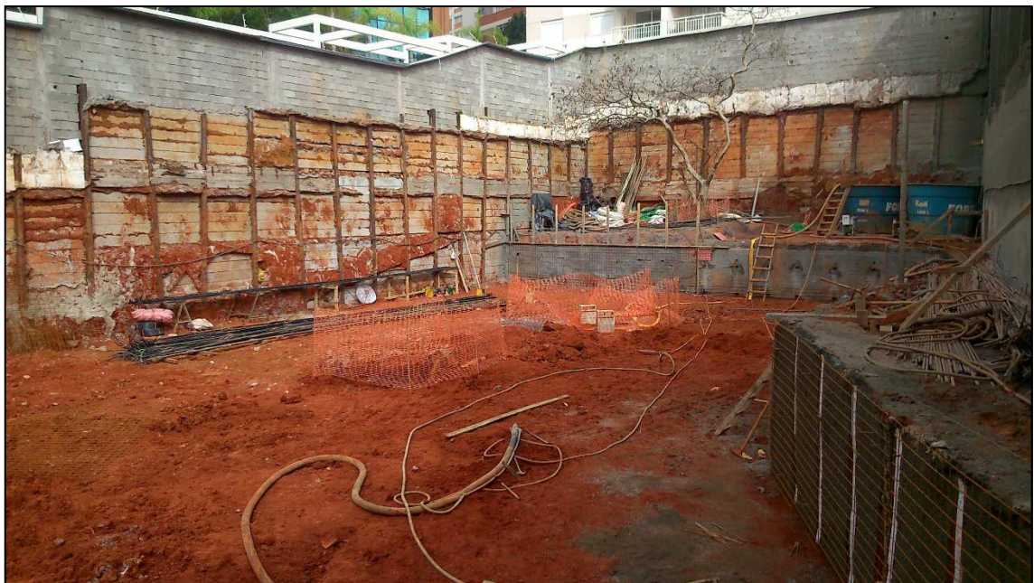
Figura 14.62 - Vista perfis de aço da contenção do prédio vizinho lateral (05/06/14).
