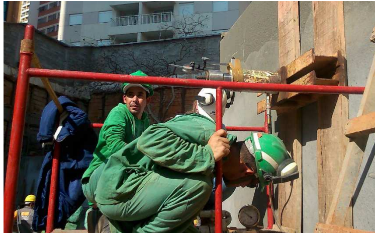
Figura 17.14 - Base magnética apoiada sobre o macaco hidráulico com o auxílio de fita adesiva. (02/07/14)
