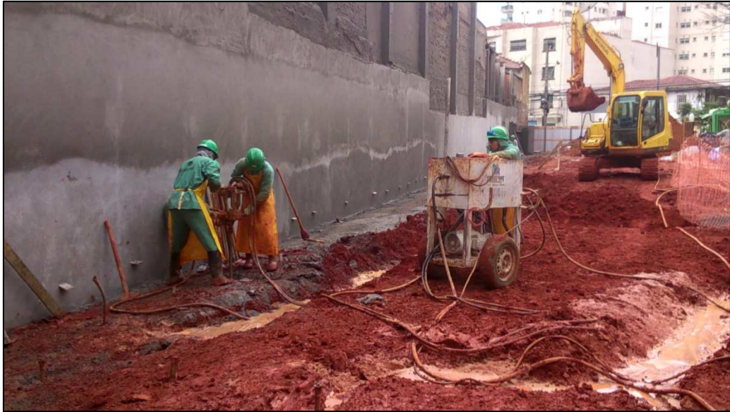
Figura 14.50 - Perfuração grampo vertical (28/05/14).
