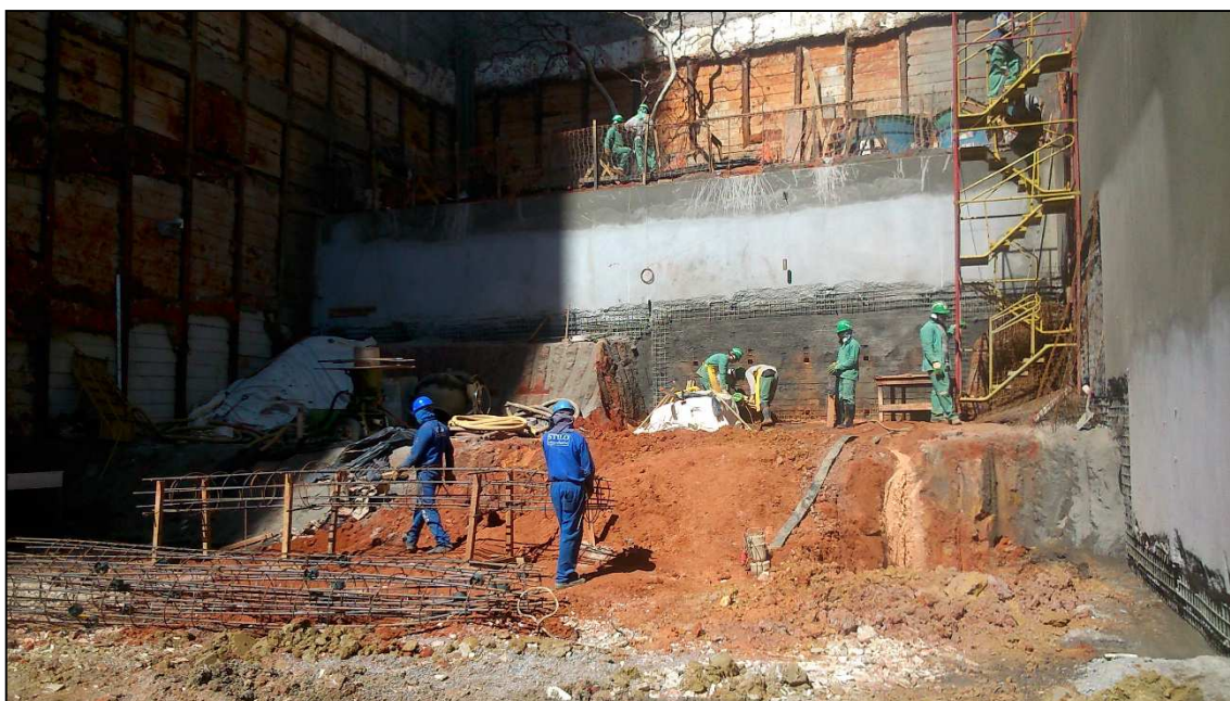
Figura 14.118 - Desenvolvimento de atividades na parede do fundo (06/08/14).
