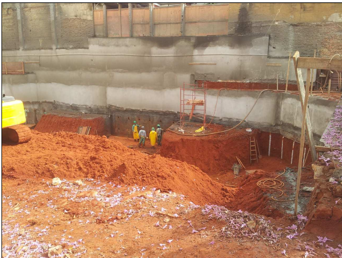
Figura 14.90 - Execução de solo grampeado na região lateral do terreno (11/07/14).
