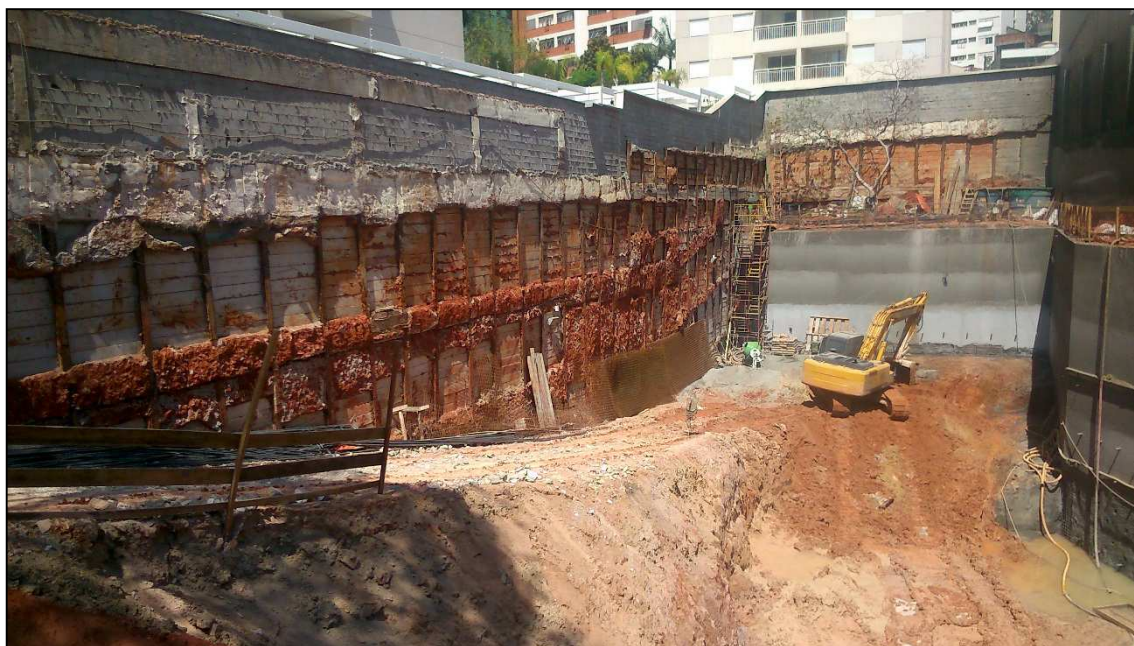
Figura 14.147 - Vista geral do canteiro. (11/09/14)
