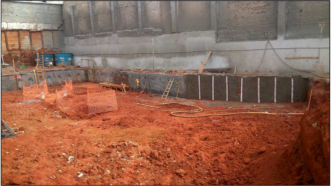
Figura 14.58 - Execução da segunda linha de grampos (05/06/14).
