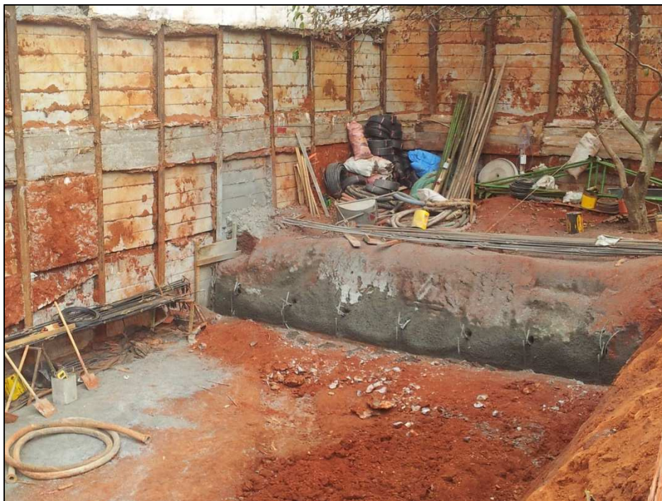
Figura 14.24 - Primeira linha de grampos do fundo da contenção (25/04/14).
