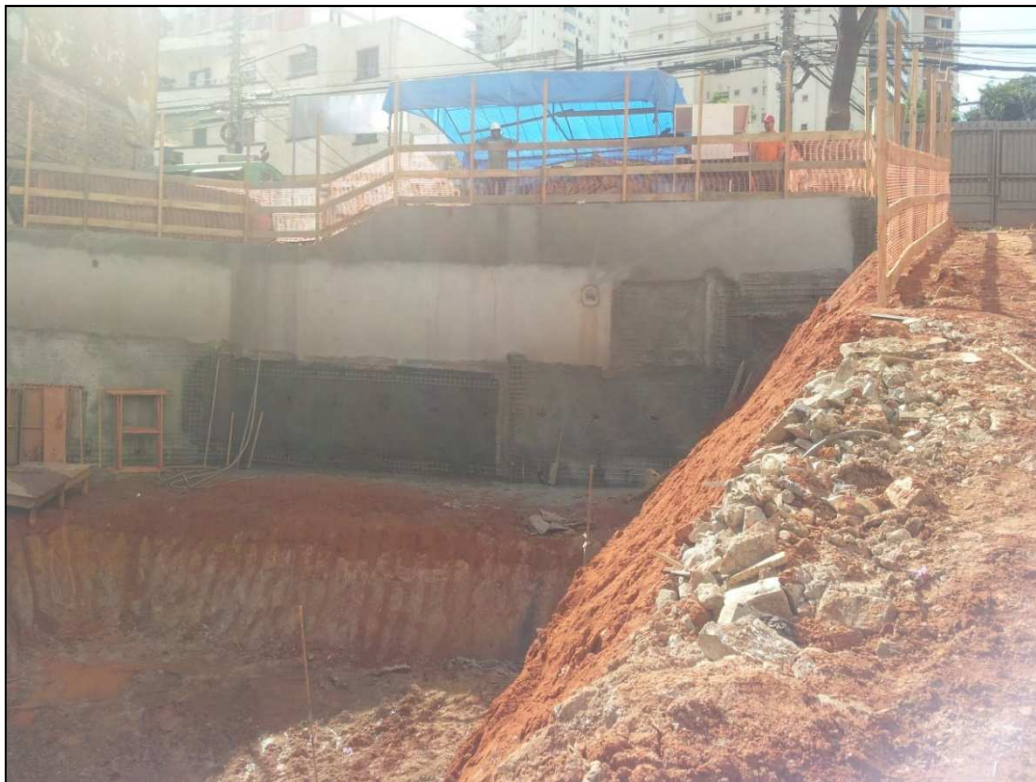
Figura 14.101 - Vista da parede do subsolo da frente do terreno (17/07/14).
