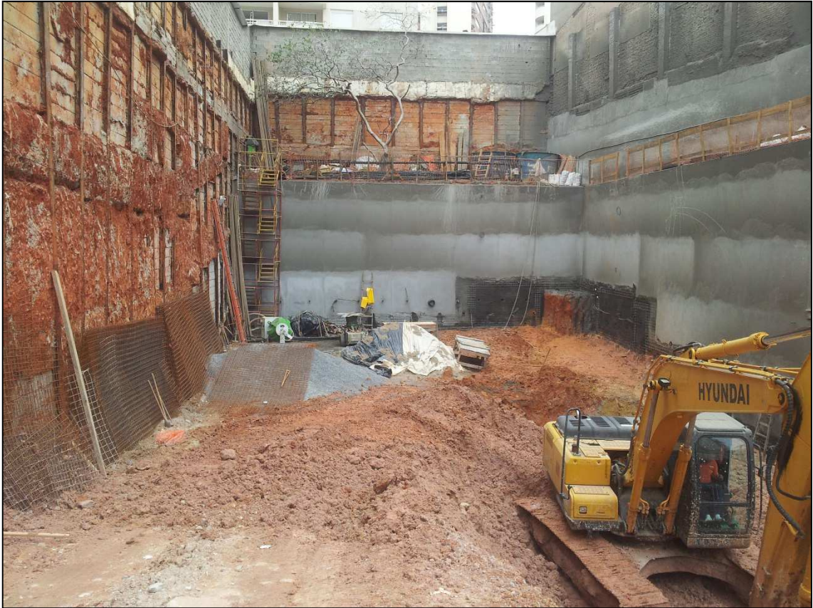
Figura 14.140 - Vista do fundo do terreno (29/08/14).
