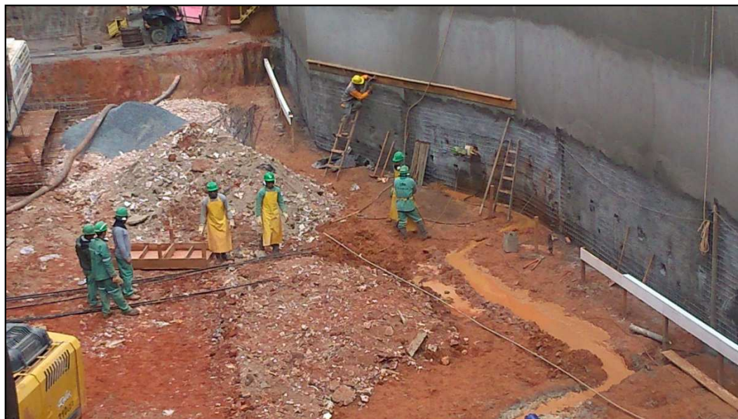
Figura 14.110 - Fixação de gabarito (29/07/14).
