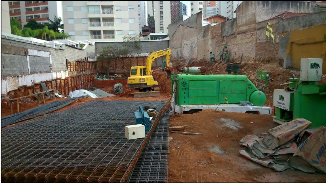
Figura 14.12 - Detalhe das telas já entregues no canteiro (09/04/14).
