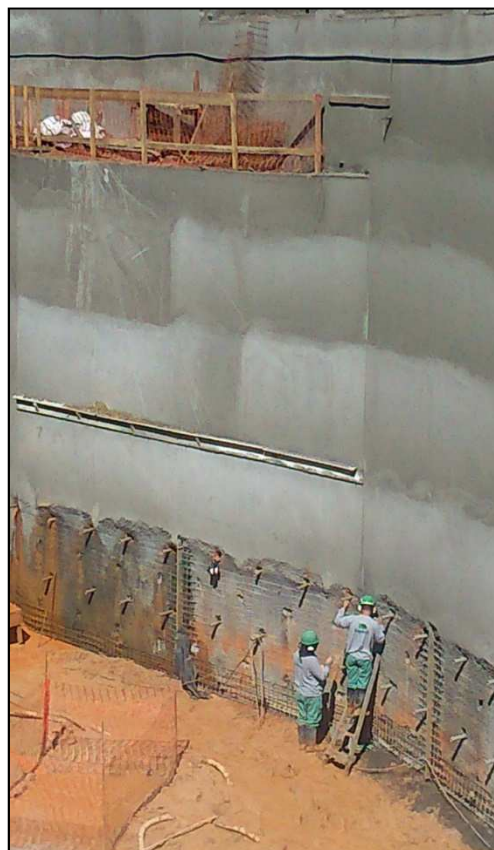
Figura 14.135 - Ajuste na colocação de DHP (27/08/14).
