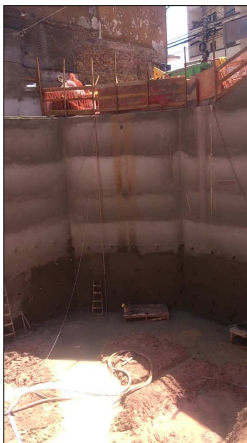
Figura 14.153 - Chanfro na região da frente do terreno (11/09/14)
