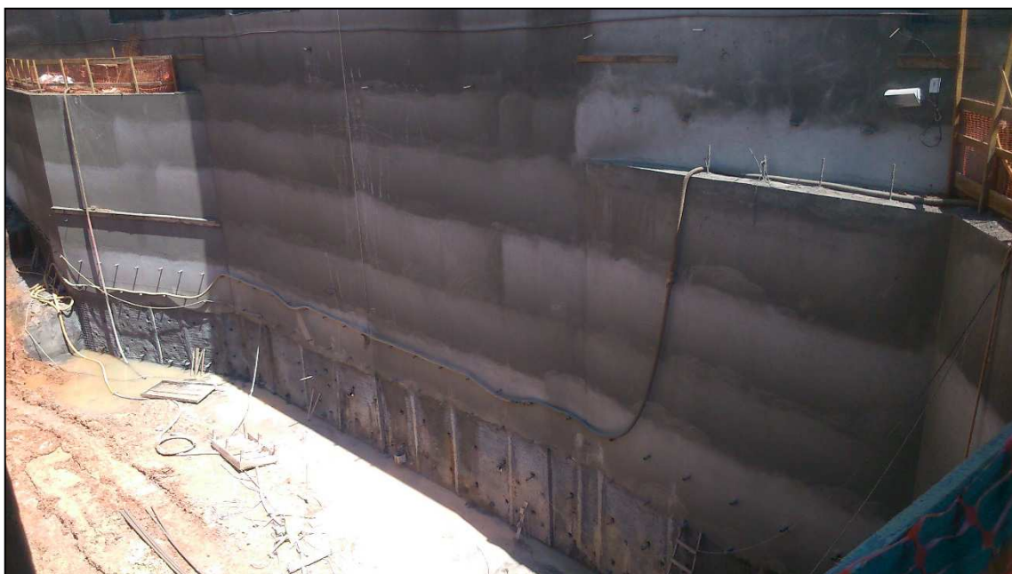
Figura 14.151 - Vista dos grampos da parede lateral, na divisa com as casas (11/09/14)
