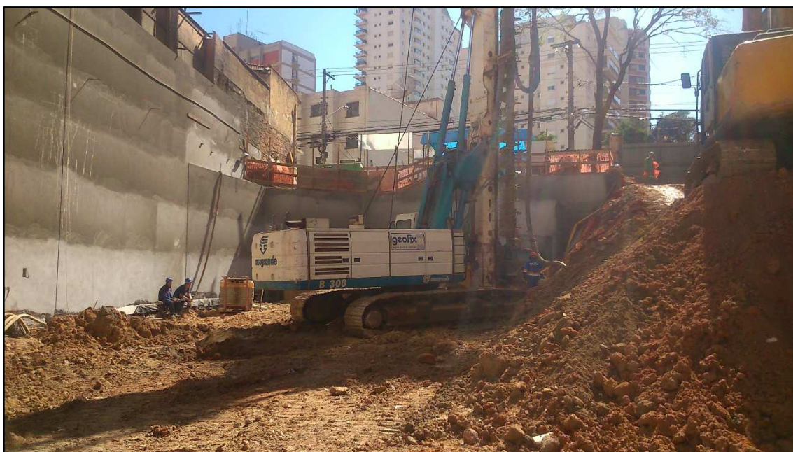
Figura 14.120 - Perfuratriz posicionada na região da frente do terreno (06/08/14).
