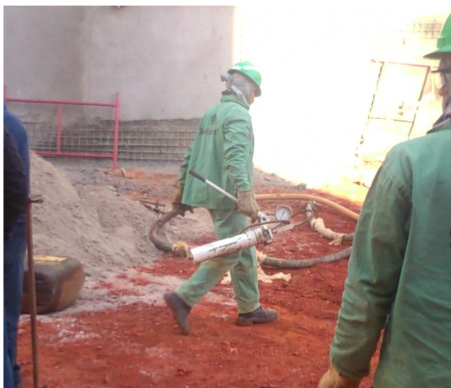
Figura 17.16 - Funcionário carregando a bomba hidráulica para o local do primeiro ensaio. (02/07/14)
