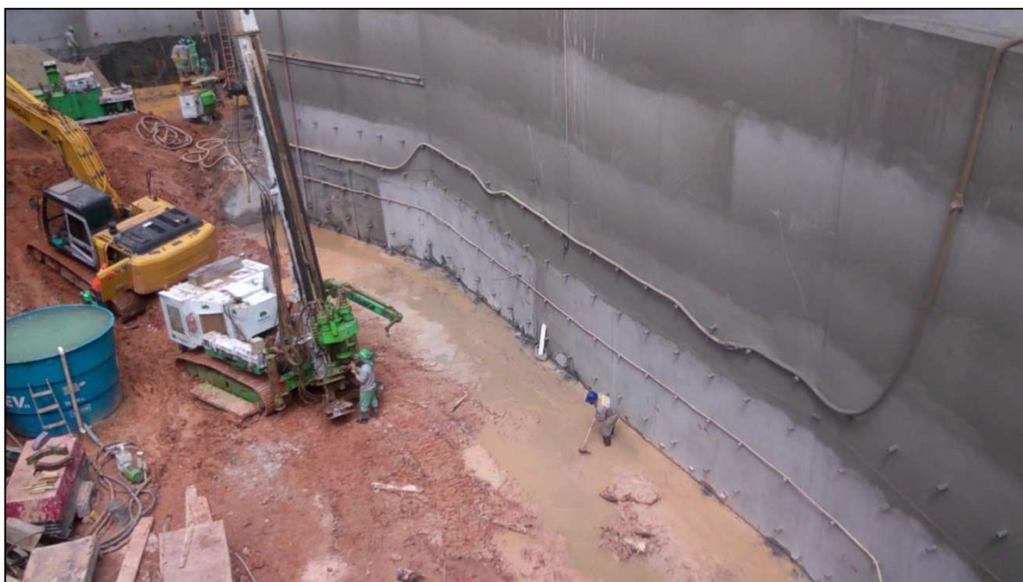
Figura 14.160 - Parede lateral da contenção (17/09/14)
