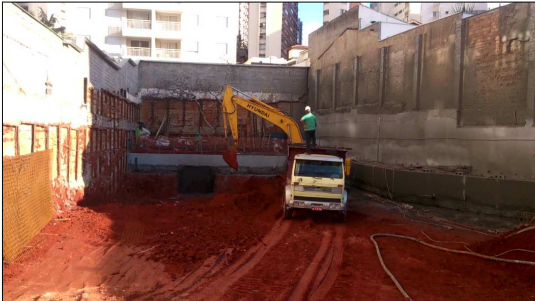
Figura 14.68 - Vista geral do canteiro (11/06/14).
