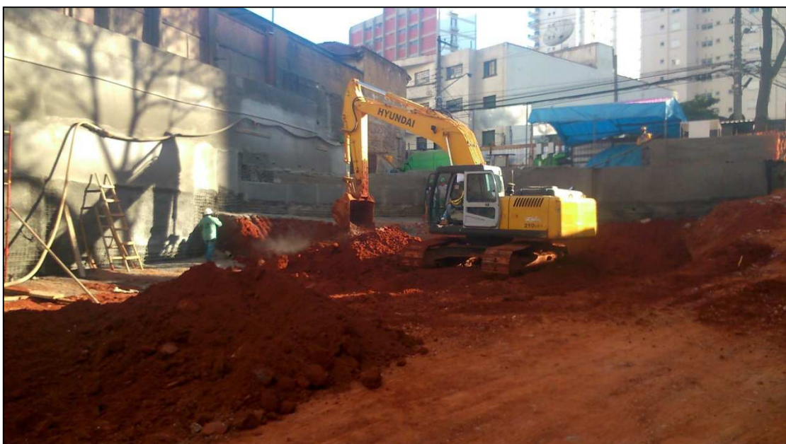
Figura 14.85 - Escavação na região da frente do terreno (02/07/14).
