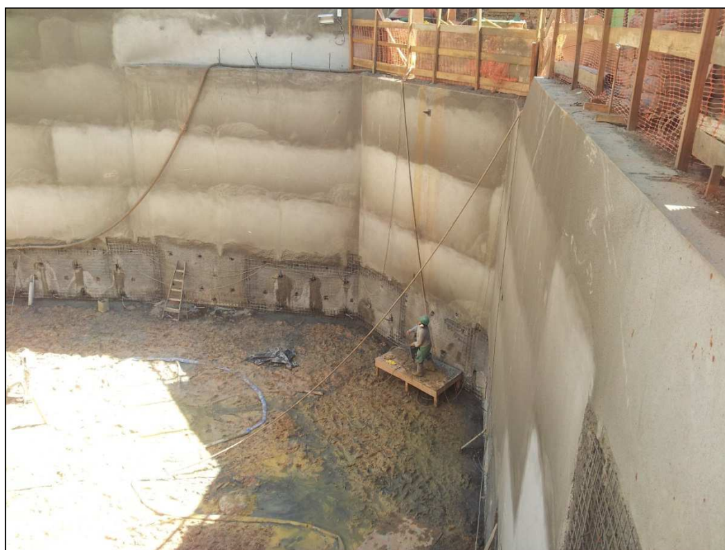
Figura 14.131 - Grampos nas paredes lateral e da frente, já sem as bermas (22/08/14).
