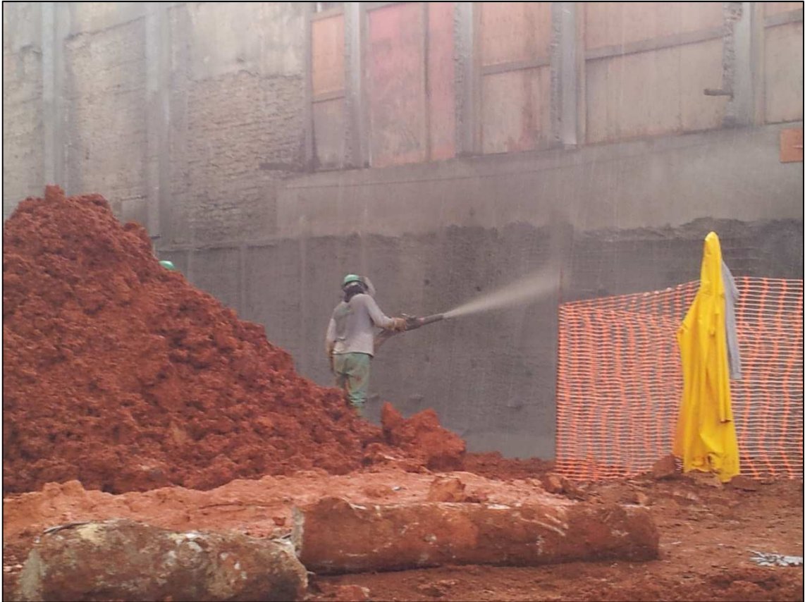
Figura 14.47 - Execução do acabamento em concreto projetado (23/05/14).
