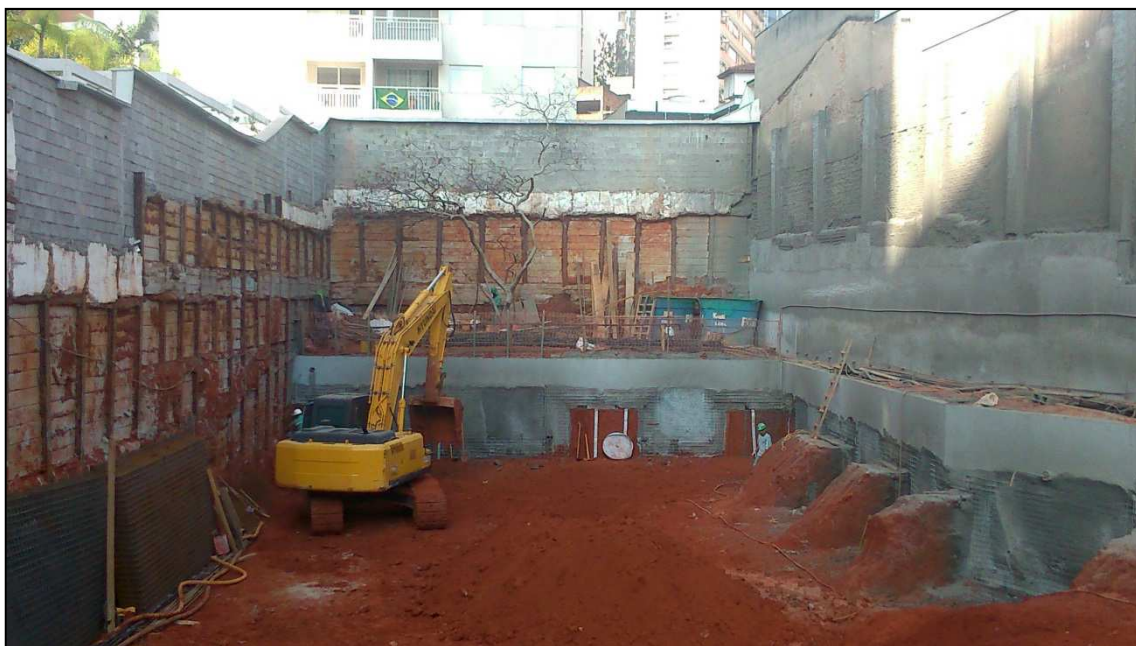
Figura 14.70 - Vista da escavação em bermas, na região do fundo do terreno (19/06/14).
