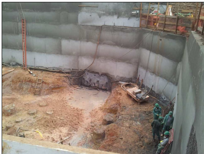
Figura 14.125 - Execução de grampos na parede lateral, próxima à entrada do terreno (13/08/14).
