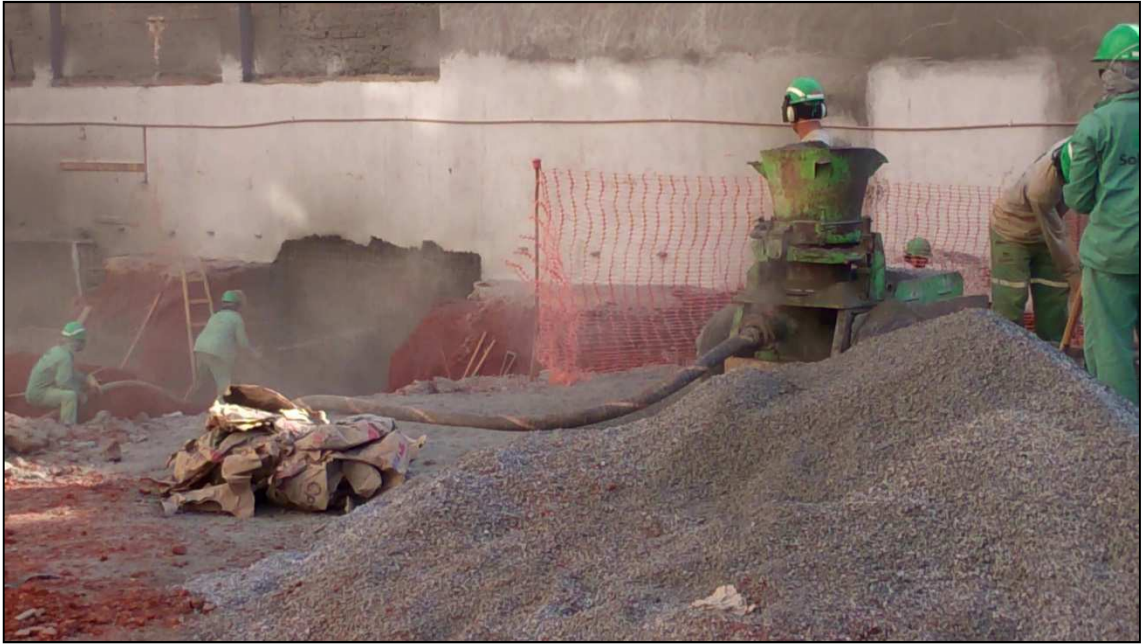
Figura 14.65 - Execução de concreto projetado (11/06/14).
