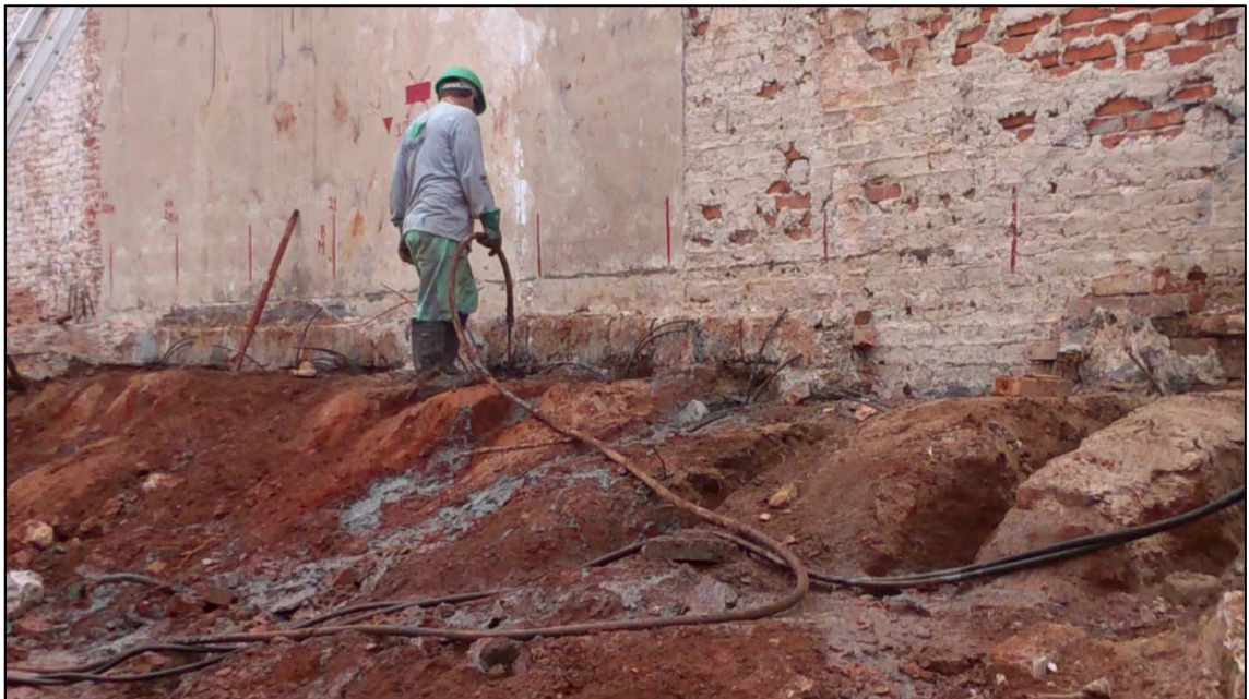
Figura 14.19 - Complementação dos furos com calda de cimento após injeções (16/04/14).
