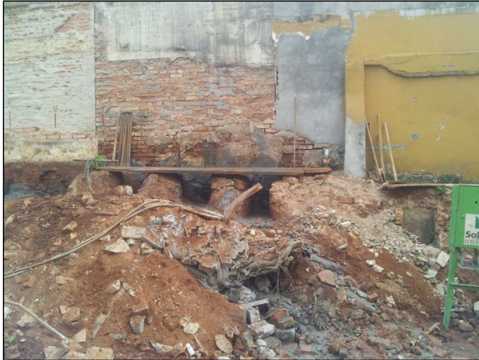
Figura 14.14 - Execução dos cavaletes (11/04/14).
