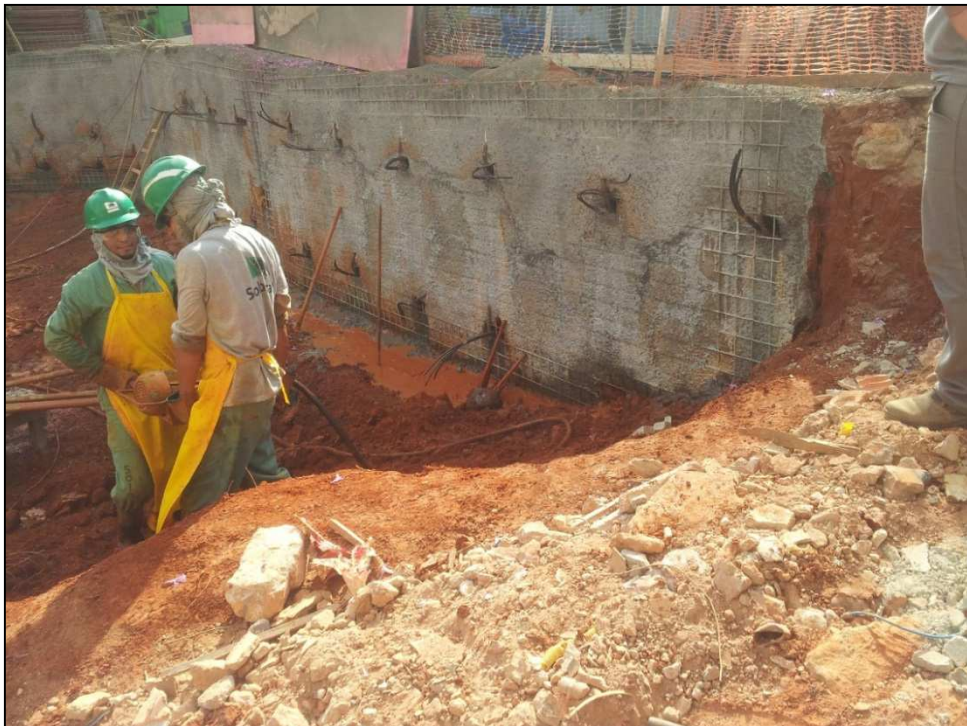
Figura 11.80 - Solo grampeado na parede do subsolo na região da frente do terreno (27/06/14).
