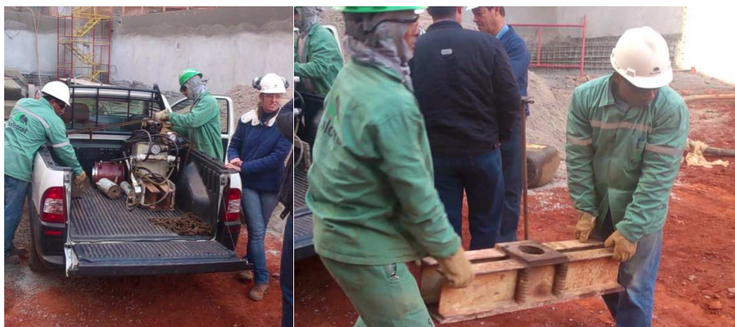
Figura 17.9 - Chegada dos equipamentos dos ensaios e funcionários da Solotrat carregando a mesa de reação para posicioná-la no grampo G.1. (02/07/14)
