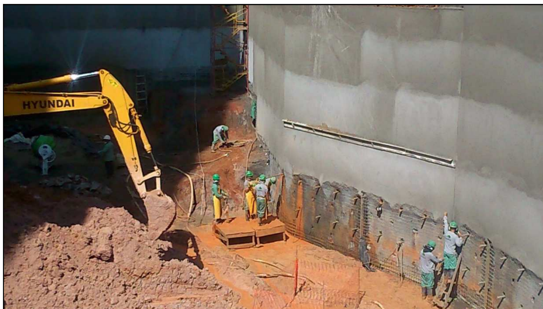
Figura 14.136 - Perfuração para DHP (27/08/14).
