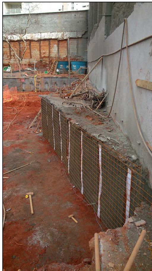
Figura 14.59 - Vista da parede lateral (05/06/14).
