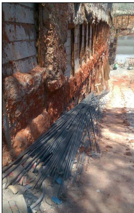
Figura 14.148 - Aço estocado na rampa de acesso (11/09/14)
