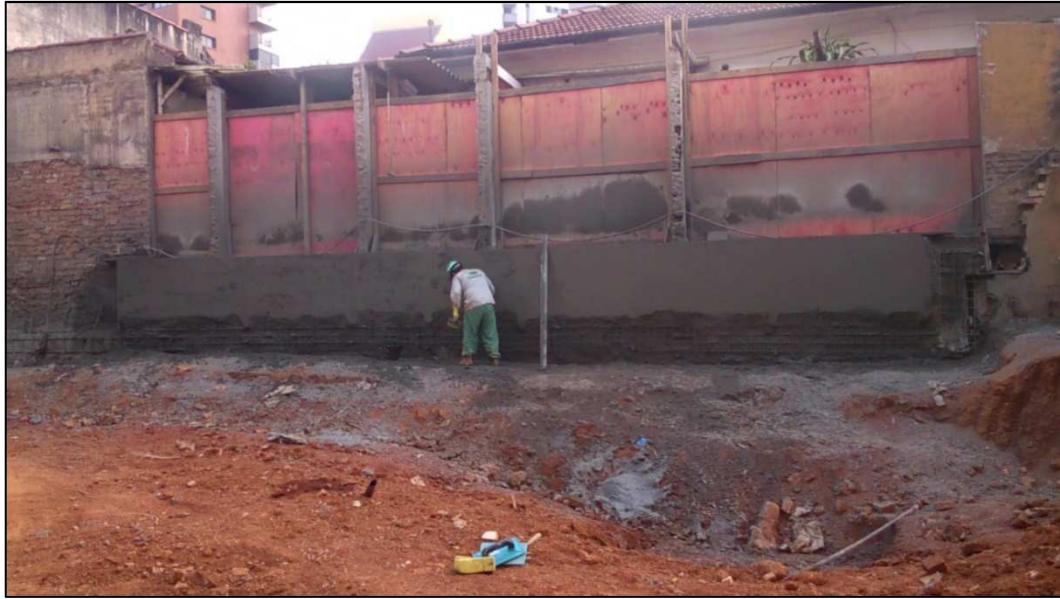
Figura 14.40 - Acabamento do paramento (14/05/14).
