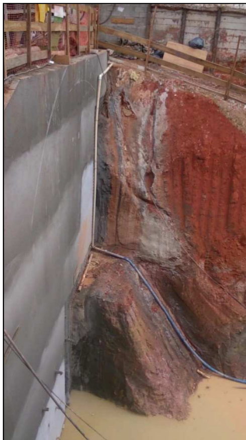
Figura 14.178 - Topo da rampa (03/10/14).
