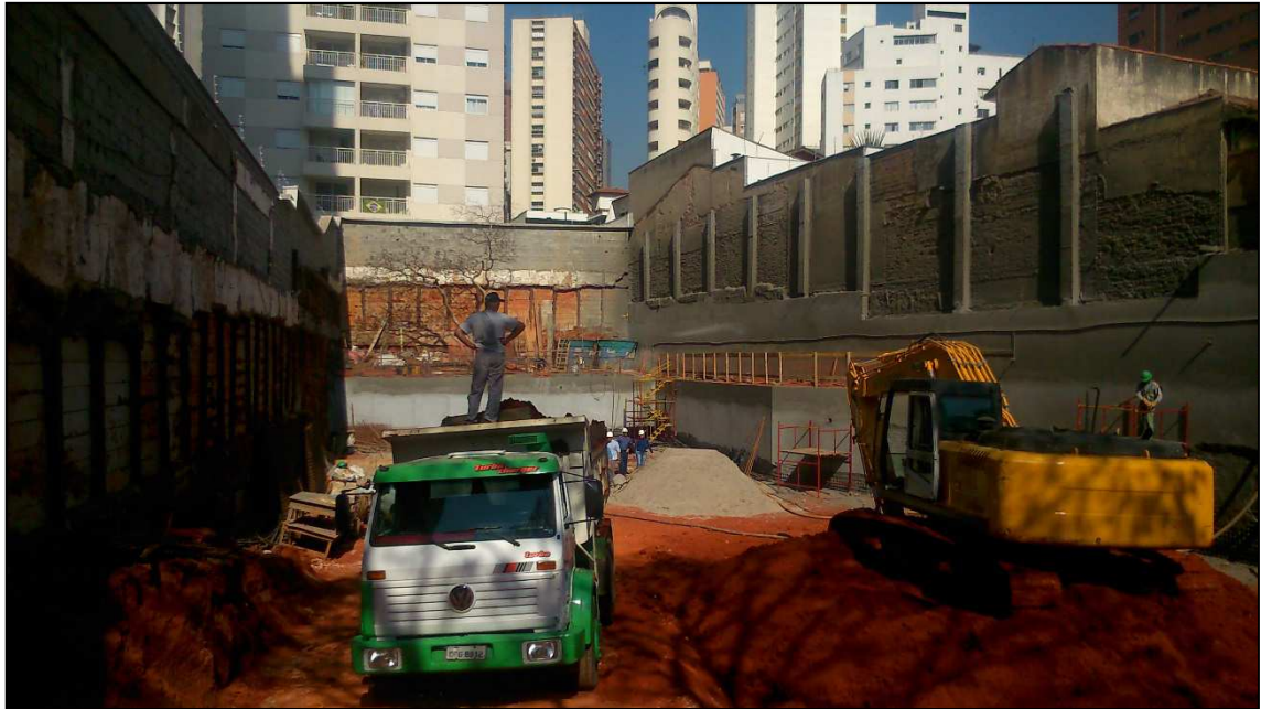
Figura 14.82 - Vista geral do canteiro (02/07/14).
