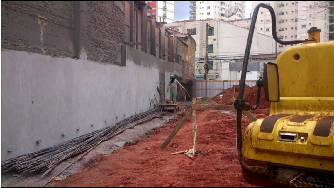
Figura 14.56 - Retorno de calda de cimento. (28/05/14)
