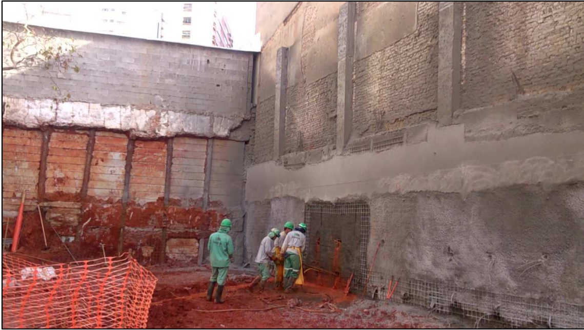
Figura 14.45 - Execução de grampo (21/05/14).
