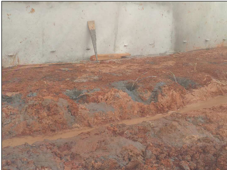
Figura 14.51 - Linha de grampos verticais (30/05/14).
