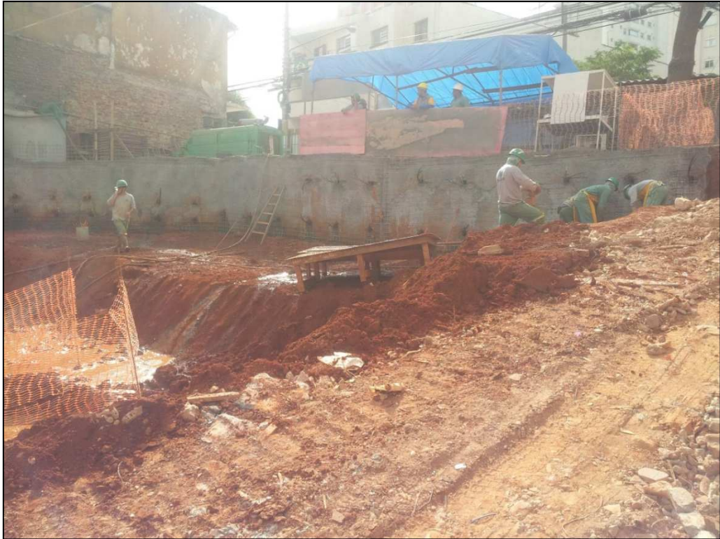
Figura 11.79 - Solo grampeado na parede do subsolo na região da frente do terreno (27/06/14).
