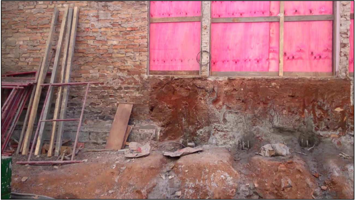
Figura 14.32 - Detalhe do fim da viga baldrame (30/06/14).
