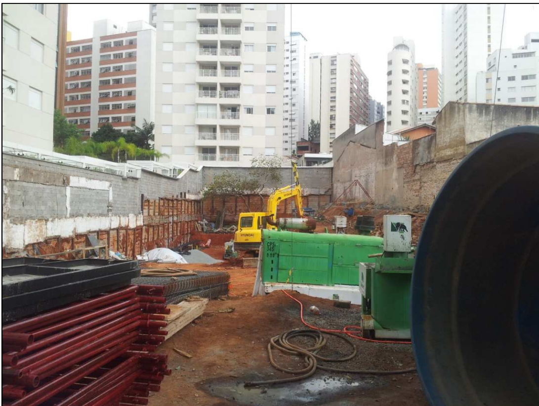
Figura 14.6 - Foto do terreno, em que é possível visualizar o prédio residencial vizinho (Torre Ipê – Condomínio Vergê Perdizes), localizado ao fundo (11/04/14).
