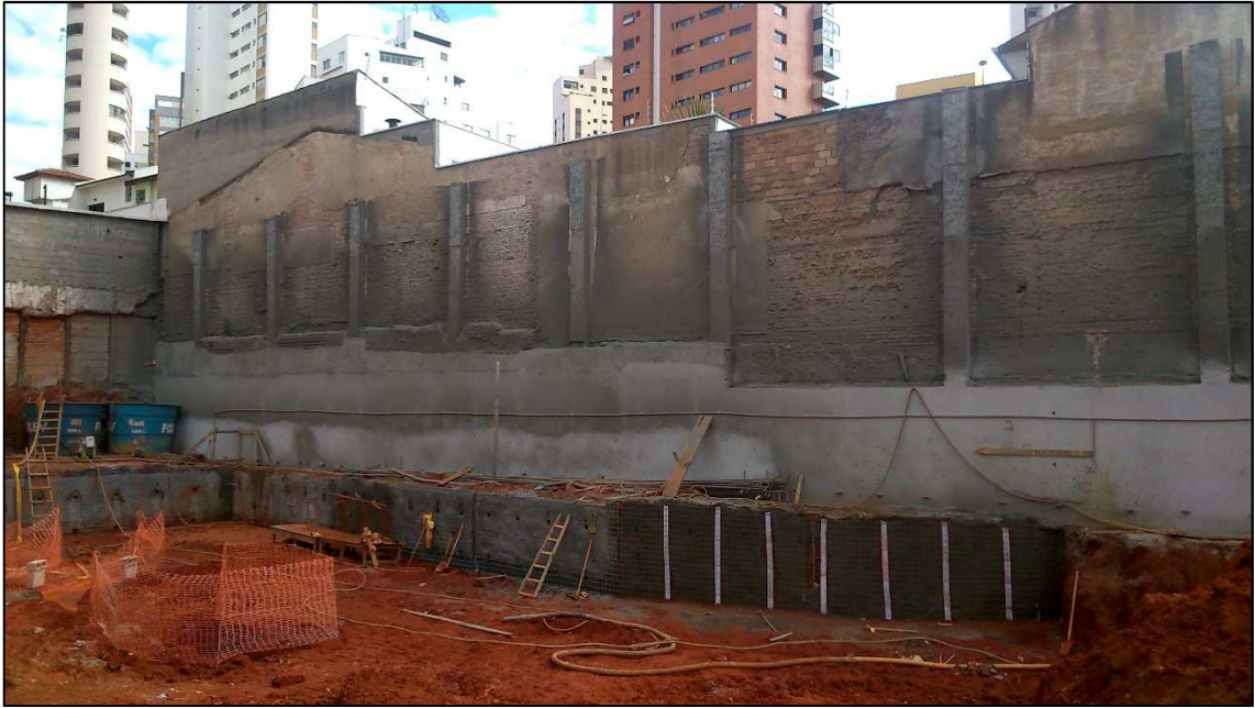
Figura 14.63 - Vista geral do canteiro (05/06/14).
