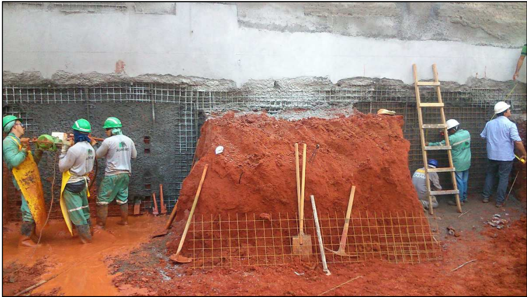
Figura 14.42 - Detalhe furo em escavação alternada (14/05/14).
