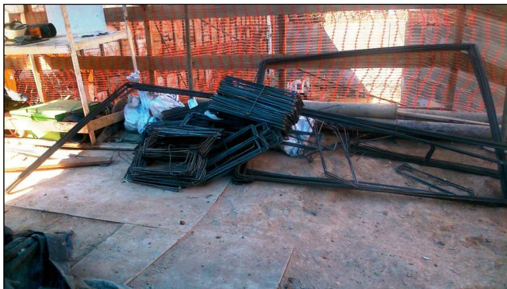
Figura 14.180 - Armação dos blocos. (08/10/14)
